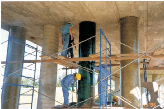
(a) Réhabilitation du viaduc de l'autoroute 10 de Saint-Étienne-de-Bolton.
