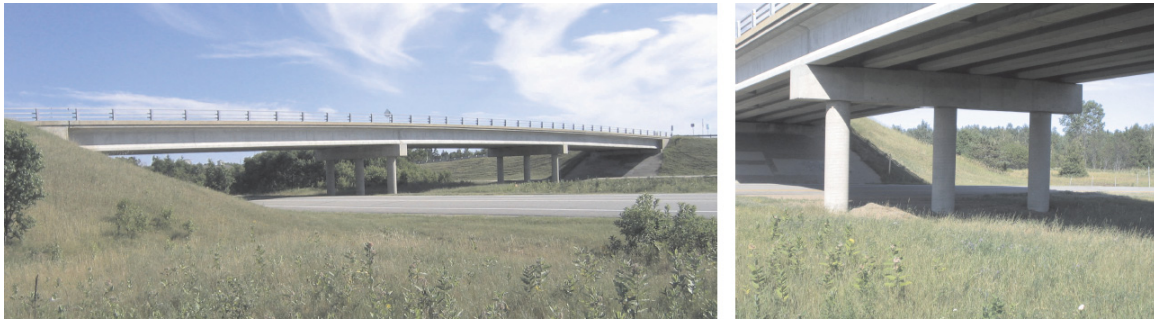
Figure 1.2 – Vue d'ensemble et vue d'un appui [50].
