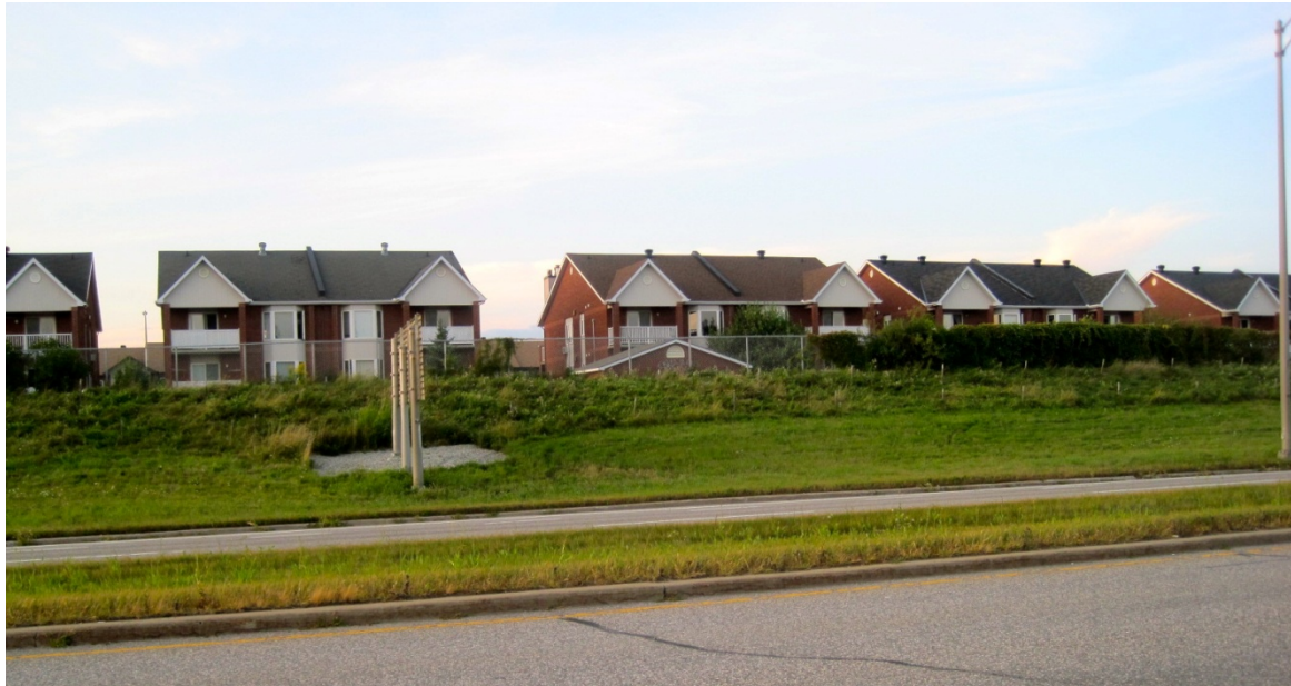
Figure 3.4 : Photographie du site de l'autoroute 5 – phase I
