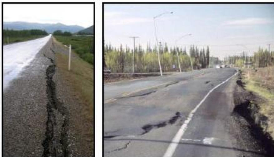
**Figure 4.7 : Exemples de fissures longitudinales dans l'accotement et sur la chaussée causées par une rotation de l'épaulement** (tirée de : Doré et Beaulac, 2007, p.10)
