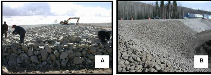
**Figure 5.5 : Exemples d'un remblai à convection, (a) Tibet, (b) Alaska** (tirée de : Voyer, 2009, p. 61)
