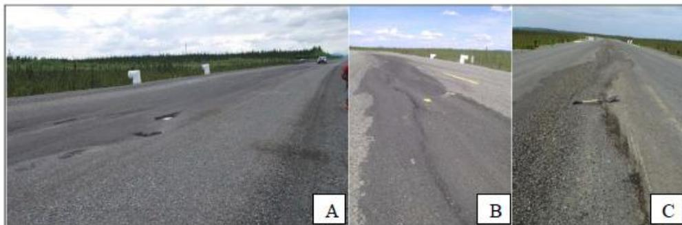
**Figure 4.3 : Évolution sur trois années d'une dépression au centre d'une route au Yukon** (tirée de : de Grandpré, 2012, p. 112)
