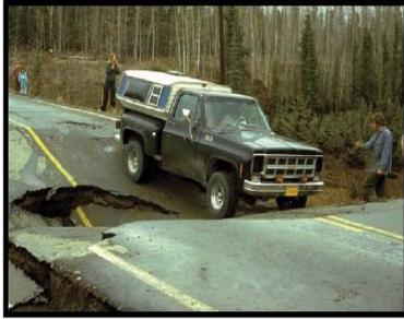
**Figure 4.2 : Affaissement d'un remblai routier en Alaska** (tirée de : Voyer, 2009, p. 51)
