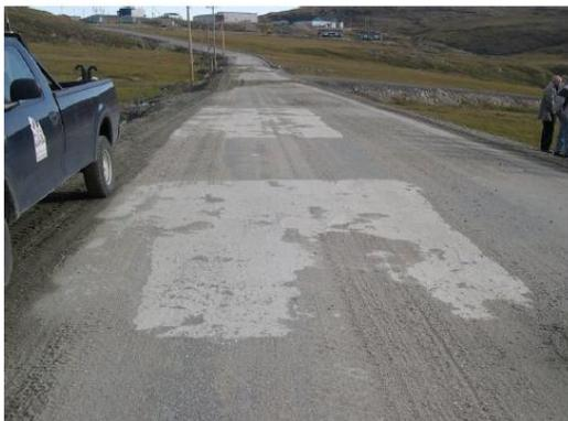
**Figure 5.2 : Exemple de détérioration de la peinture blanche** (tirée de : Doré et Voyer, 2010, p. 54)
