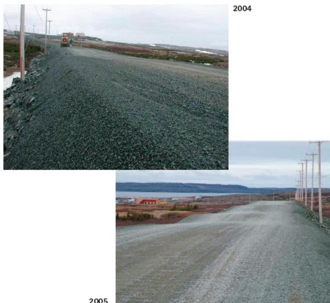
**Figure 4.4 : Évolution des affaissements sur la route d'accès à l'aéroport d'Umiujaq entre 2004 et 2005** (tirée de : Guimond et autres, 2008, p. 32)
