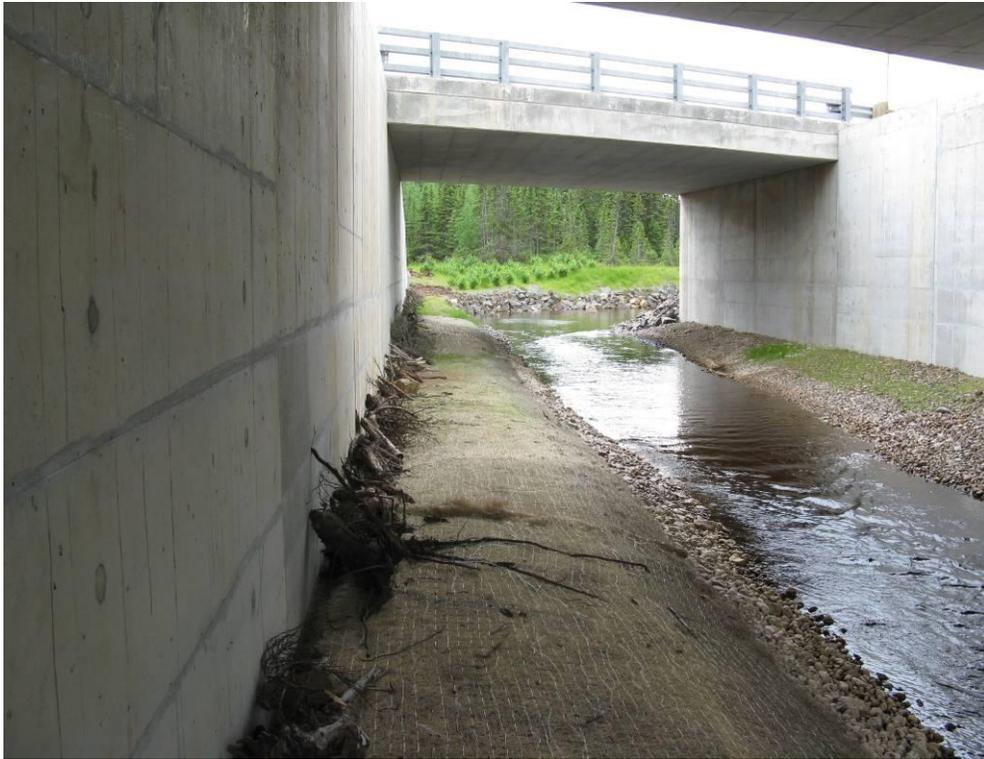
**Figure 2.6.** Lit mineur construit à la décharge du lac Horatio-Walker sous la route 175, au Québec. Photo : MTQ, photo non publiée.
