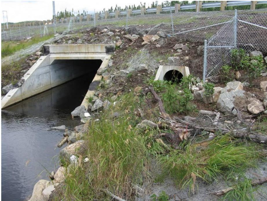
**Figure 2.1.** Tuyau en béton armé de 600 mm de diamètre (TBA 600) à proximité du ponceau du ruisseau des Brûlés sous la route 175. Photo : MTQ, photo non publiée.
