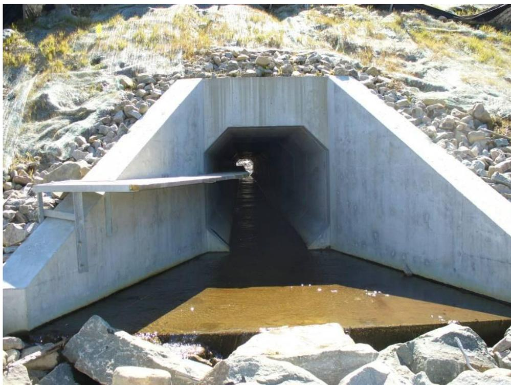
**Figure 2.4.** Tablette en bois en porte-à-faux installée à l'intérieur du ponceau d'un ruisseau sans nom sous la route 175. À noter que la construction de ce passage n'est pas encore terminée, car l'aménagement entre le milieu adjacent et le passage n'est pas encore fait. Photo : MTQ, photo non publiée.
