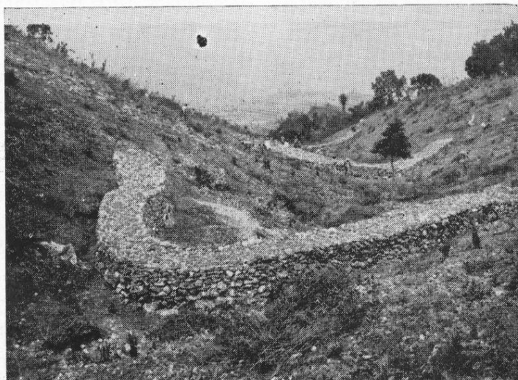
Barrage en pierres réalisé au Morne de l'Hôpital pour la protection des ravins.
