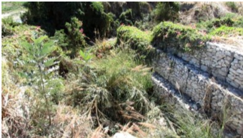
Figure 3.1 Ouvrage de gabionnage réalisé dans l’Artibonite, Haïti (Photo : Michel Toujas)
