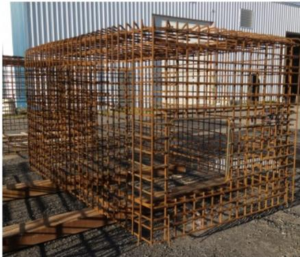
Figure 4-1 : Cage d'acier pour les chambres souterraines en acier
