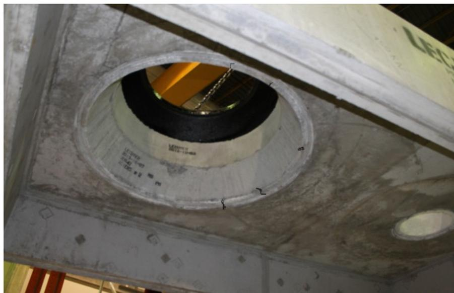
Figure 5-21 : Fissuration de l'intérieur de la chambre PRFV6
