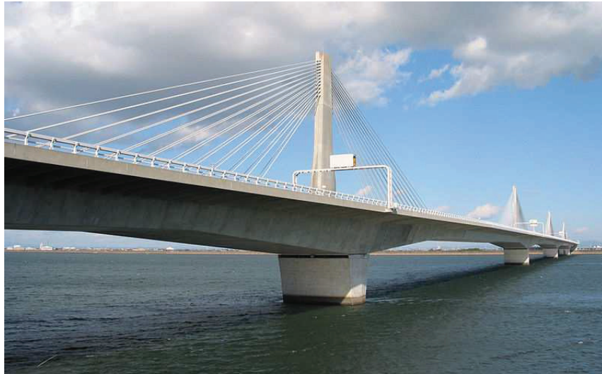
Figure 1.3 Exemple d'un pont à précontrainte extradossée : Pont Twinkle Kisogawa au Japon, 2006 [Tawashi, 2006]
