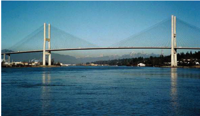
Figure 1.2 Exemple d'un pont hauban  construit apr s 1970 : Pont Alex-Fraser au Canada, 1986 [Cortright, 1995]
