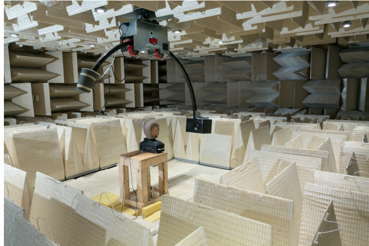
Figure 5.3 Salle anéchoïque ICAR après installation des cônes au sol avec bras automatisé.
