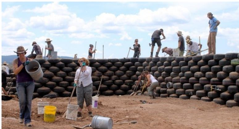
**Figure 3.10 Construction d'un géonef** (tiré de : Nardone, 2013)
