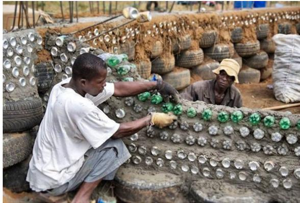
**Figure 3.11 Construction d'un géonef en projet humanitaire** (tiré de : *Earthship Bioteecture*, 2013)
