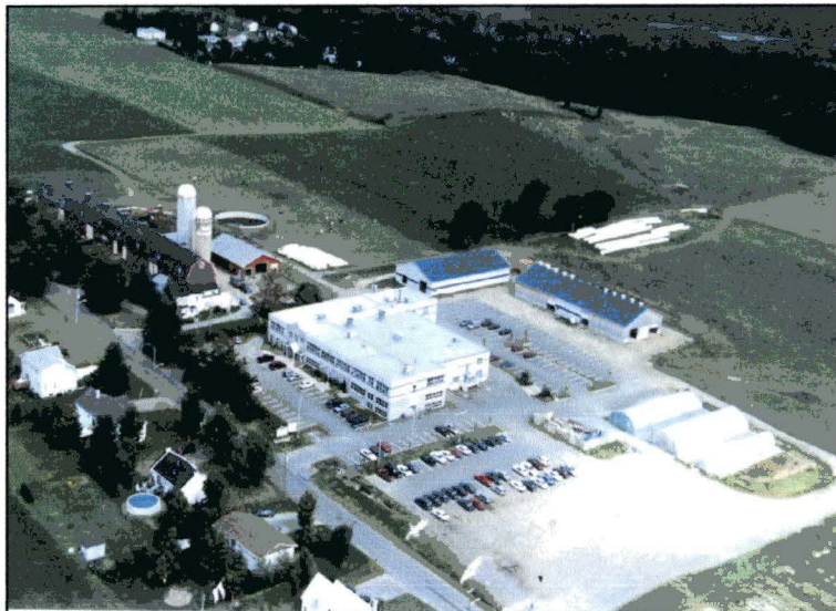
Figure 6 : Les bâtiments du site du CIARC vue du sud-est
