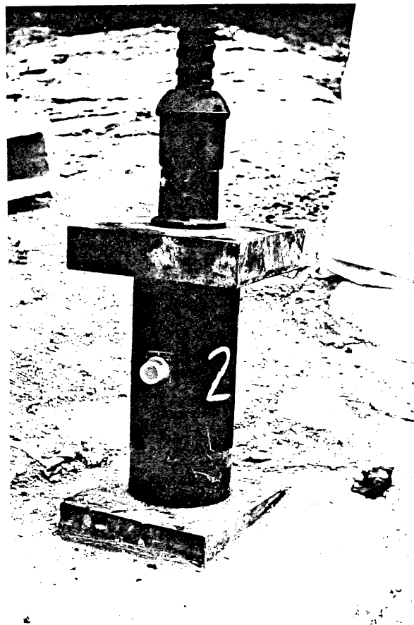
FIGURE 3.10 Vue d'un ancrage équipé d'une cellule de charge, après l'opération de blocage
