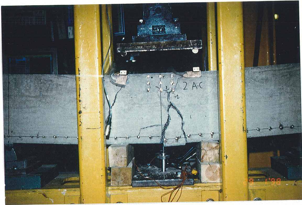
Figure 5.23 Vue de la Rupture de la poutre 2AC
