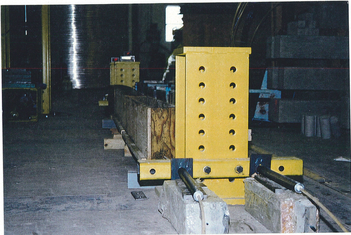
Figure 4.12 Vue de l'extrémité non chargée du lit de précontrainte
