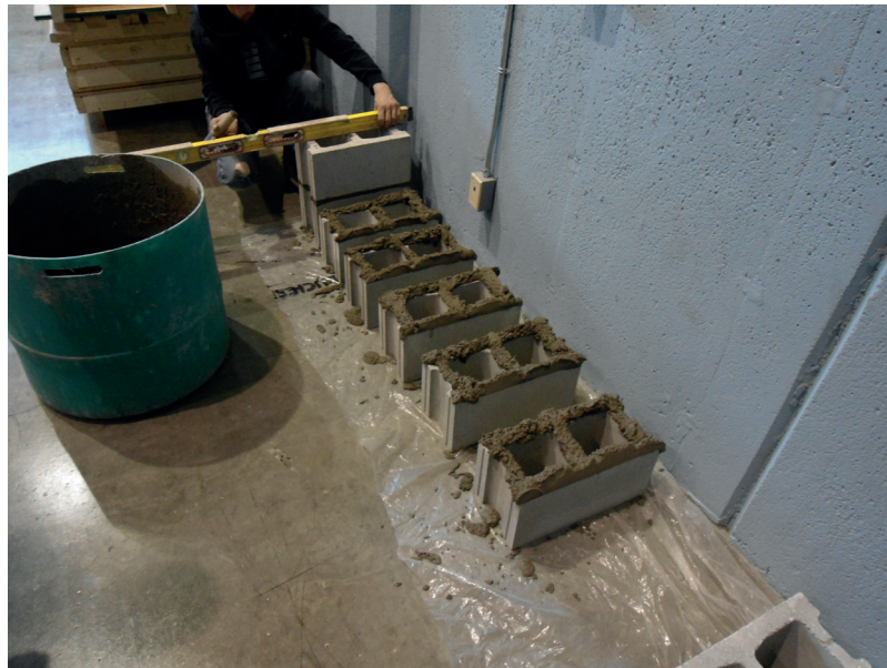
Figure A.12 Construction des primers pour les essais en compression concentrique - Mur 2
