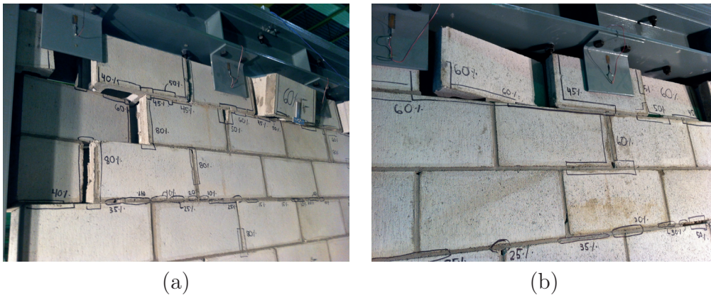
Figure 5.18 Photos de l'endommagement du mur 1 après l'essai MAL19-0.90 (a) détachement de la partie supérieure droite du mur (façade avant) (b) détachement des blocs de la première rangée (façade arrière)
