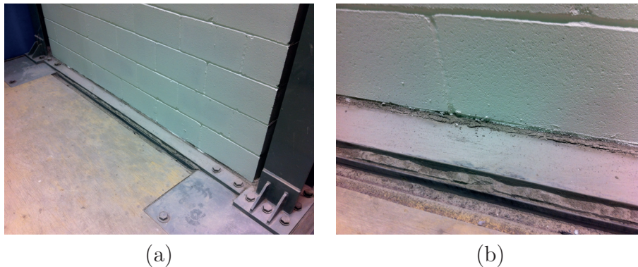
Figure 5.30 Endommagement du joint inférieur du mur après l'essai MAL2-0.10 (a) vue d'ensemble du joint inférieur (b) vue rapprochée du joint inférieur
