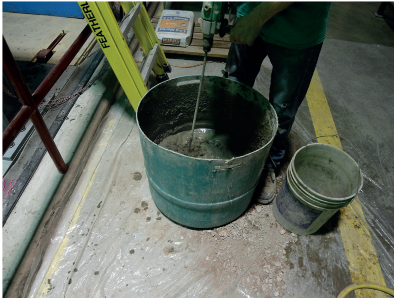
Figure A.5 Préparation du mortier - Mur 2
