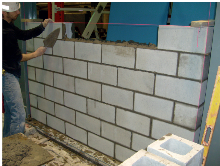
Figure A.2 Système d'alignement lors de la construction des murs - Mur 1
