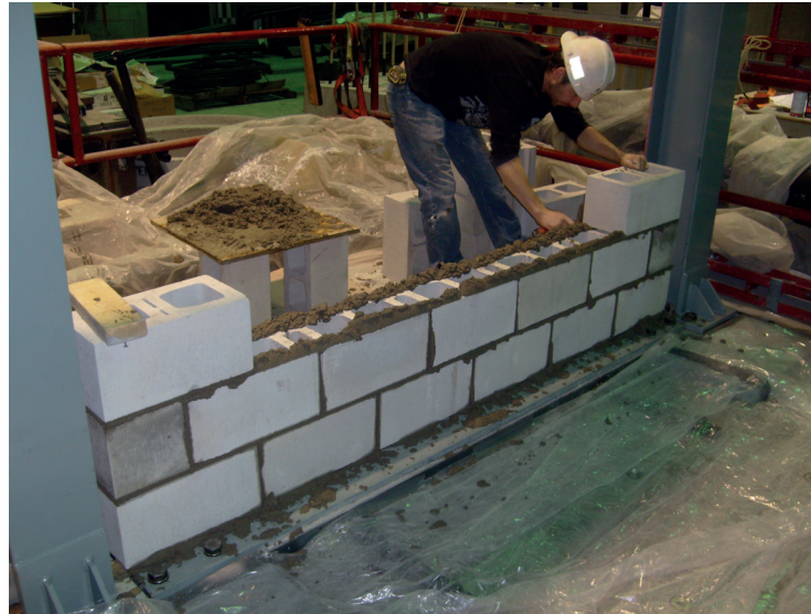
Figure A.1 Pose du mortier sur la 2 e rangée inférieure de blocs - Mur 1
