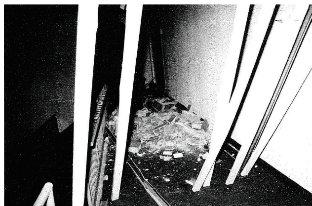
Figure 1.4 Effondrement d'un mur de cloison en blocs de béton à la polyvalente Dominique Racine à Chicoutimi lors du tremblement de terre du Saguenay en 1988 [Mitchell et al. , 1990]
