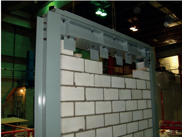
Figure A.3 Pose des deux dernières rangées de blocs - Mur 1
