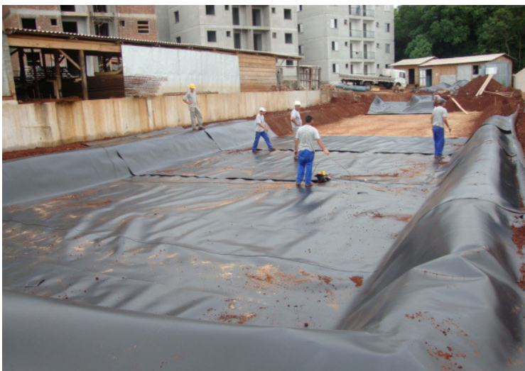
Figura 9 - Revestimento com geomembrana
