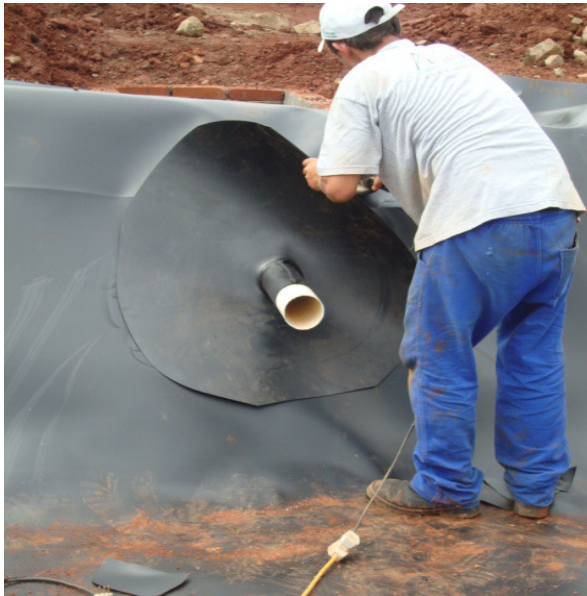
Figura 10 - Acabamento da conexão da geomembrana na entrada do Wetland
