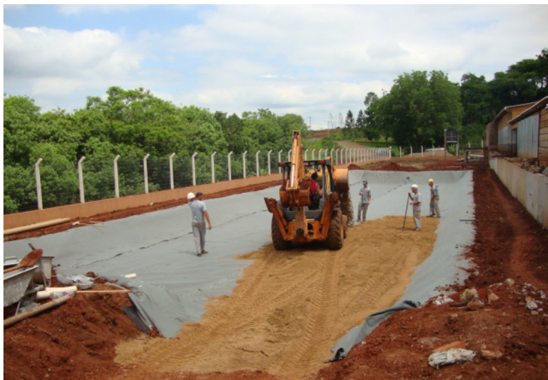
Figura 11 - Colocação do material de enchimento
