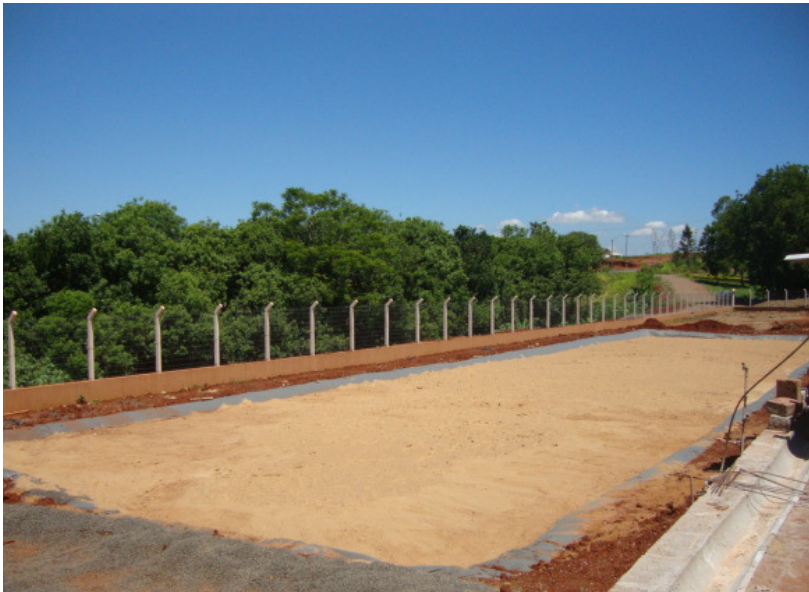
Figura 12 - Etapa completa de material de enchimento
