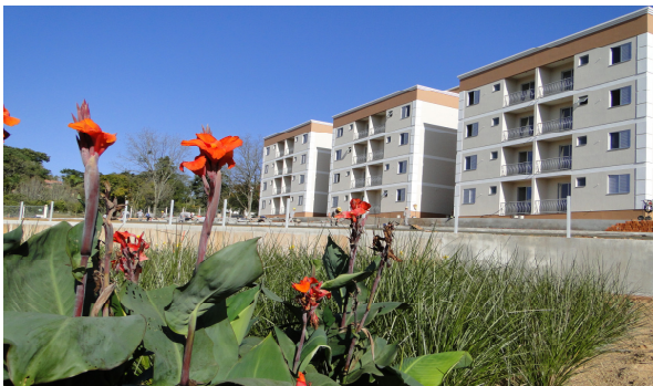
Figura 7 - Imagem dos blocos residenciais e macrófitas do Sistema de WC.
