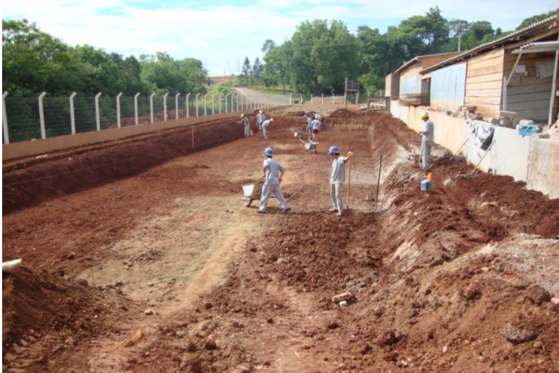
Figura 8 - Escavação e compactação
