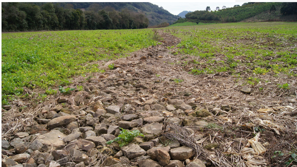
Figura 34: Pedras utilizadas para drenar córregos no ponto 60
