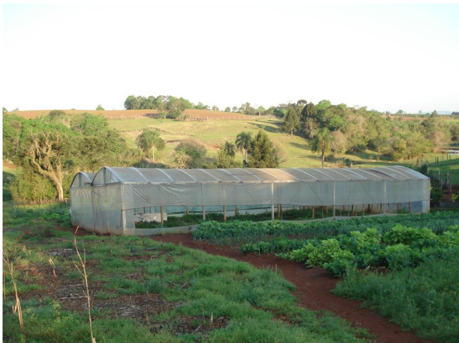
Figura 16– Vista lateral da estufa tipo arco.
