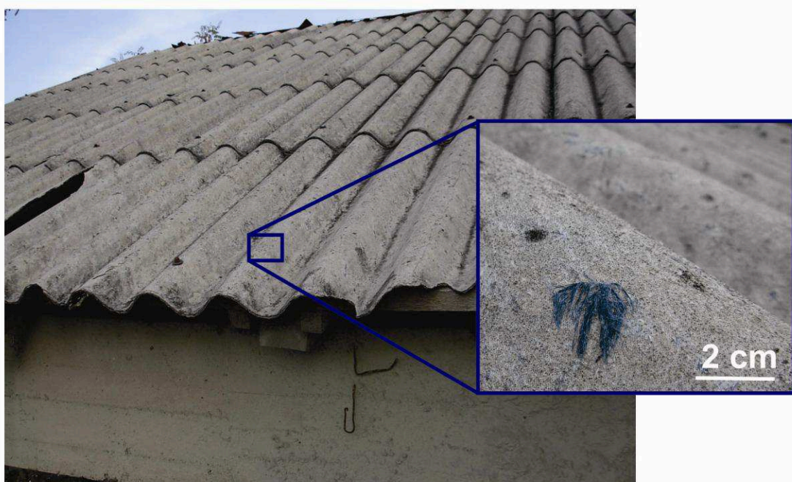
7.3. ábra: Azbeszttartalmú hullámpala („eternit”) egy bányaeépületen. A közeli felvételen jól látszik, hogy a pala szálerősítésére riebeckitazbesztet (kereskedelmi nevén krokidolitot vagy kékazbesztet) alkalmaztak. Grozdics Tibor felvételei
