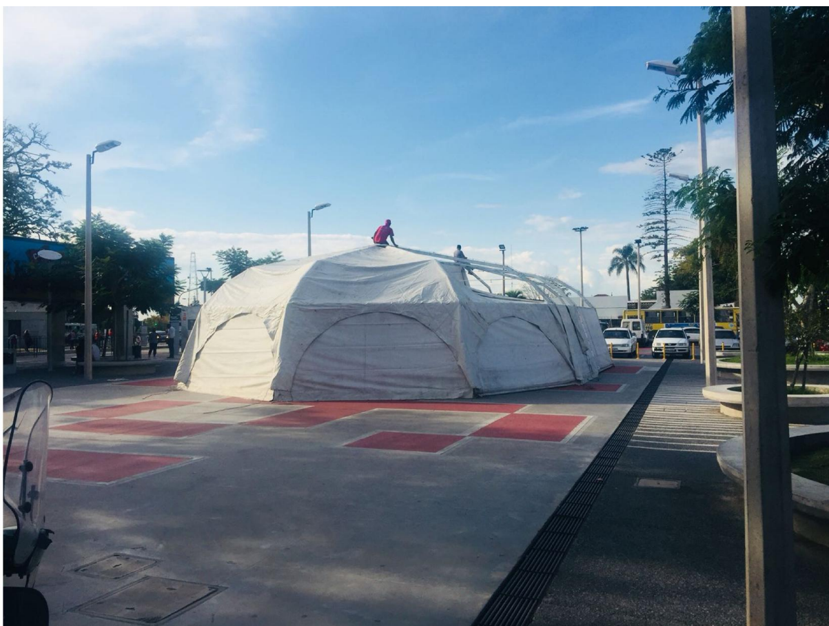
Imagen 13. Armado de la carpa en el estacionamiento del Intercambiador Belloni.
