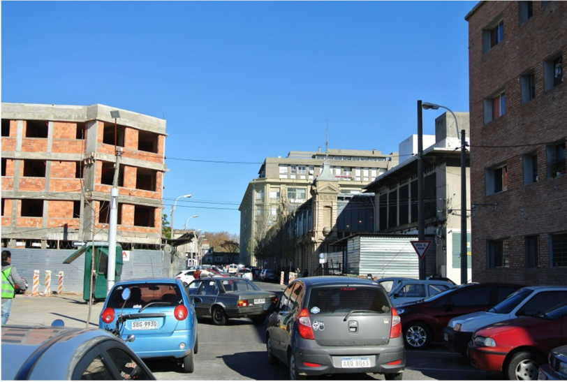
13. Cooperativas en obra
