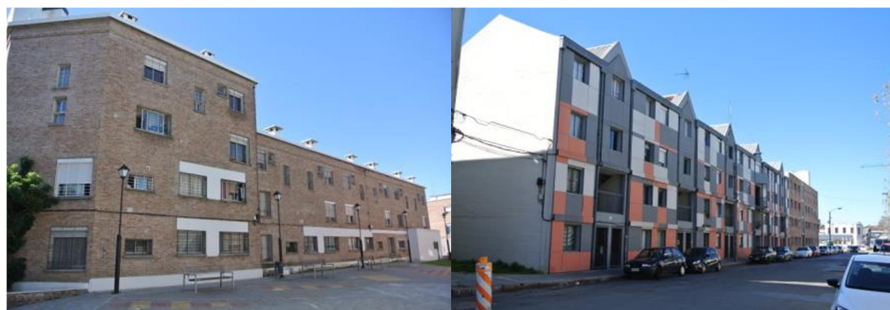
Figura 21. Cooperativas construidas. Entorno del Mercado Agrícola. (Virginia García, 2018)
