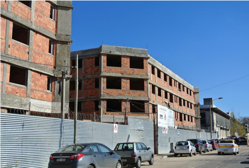
11. Cooperativas en obra
