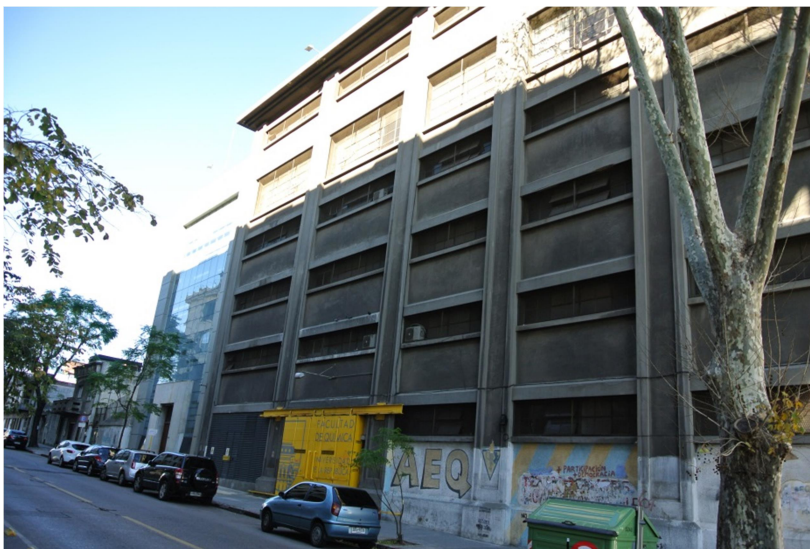
4. Edificio UdelAR (ex Alpargatas)
