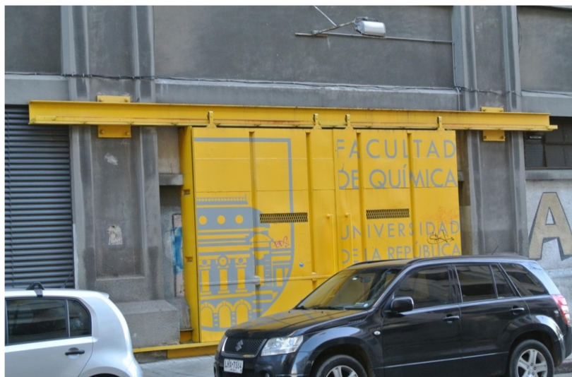
5. Edificio UdelAR (ex Alpargatas)
