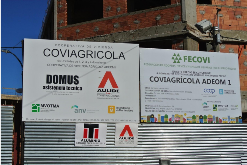
12. Cooperativas en obra
