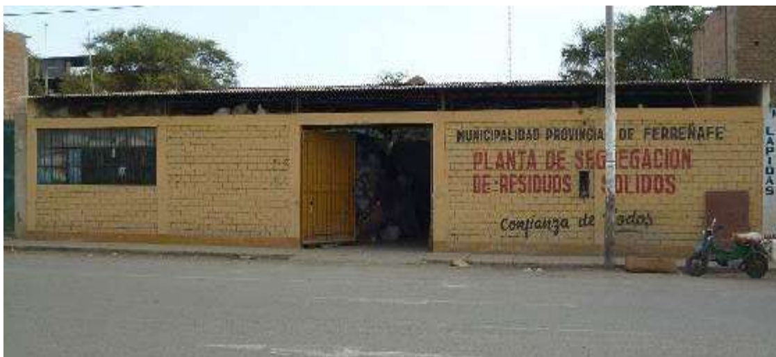
Figura 12. Vista frontal de la Planta de Segregación de Residuos Sólidos de la Municipalidad Provincial de Ferreñafe
