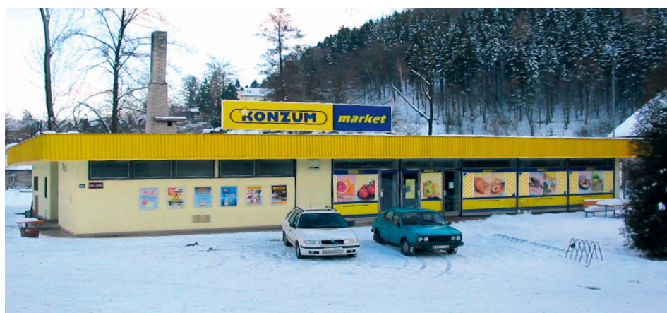
Obr. 4.3: Nákupní středisko v Potštejně (okres Ústí nad Orlicí)
