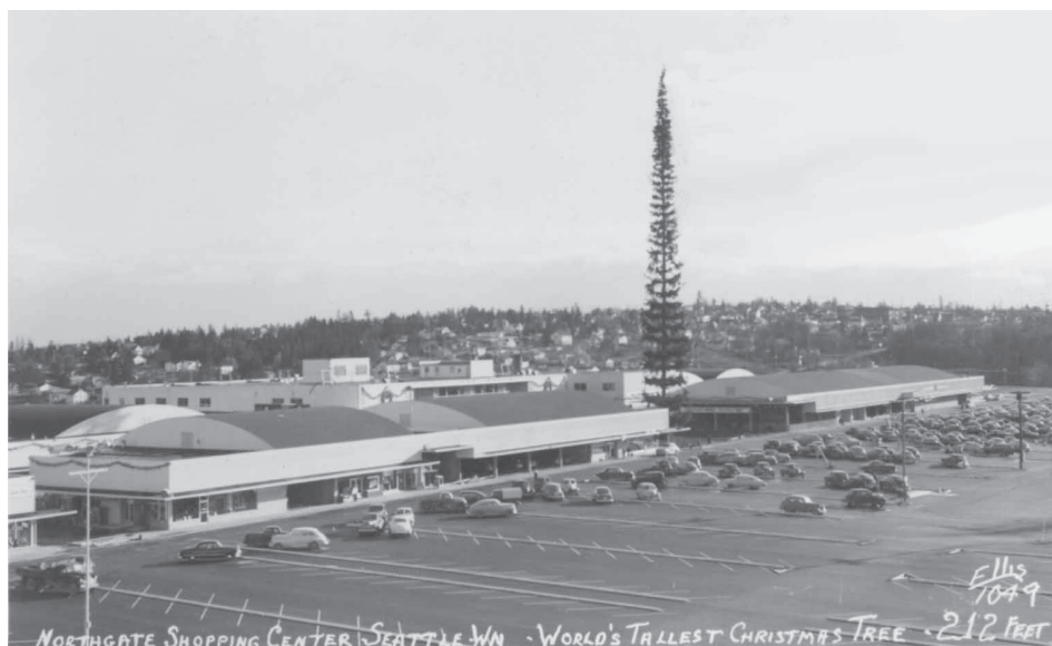
Obr. 5.2: Jedno z prvních krytých nákupních center na světě – Northgate v Seattlu
