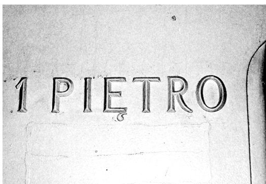
il. 40: System informacji wizualnej, Pałac Młodzieży w Katowicach, stan z 2013 roku, fot. A. Borowik
