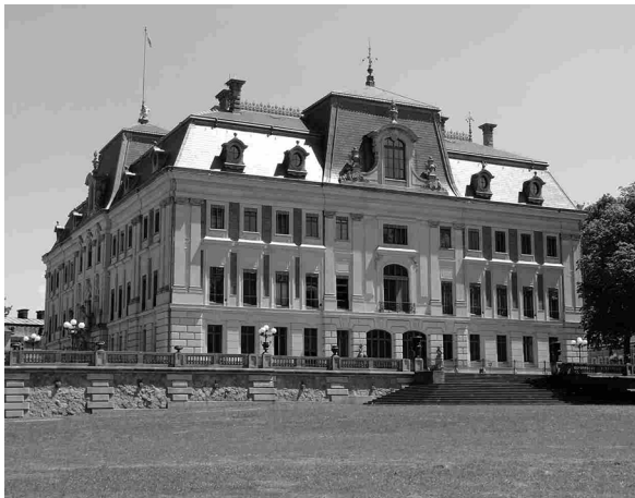
il. 1: Zamek w Pszczynie, 1870-1876 r., Hipolit Destailleur, elewacja południowa, stan z 2012 roku, fot. W. Wrona-Gaj.
