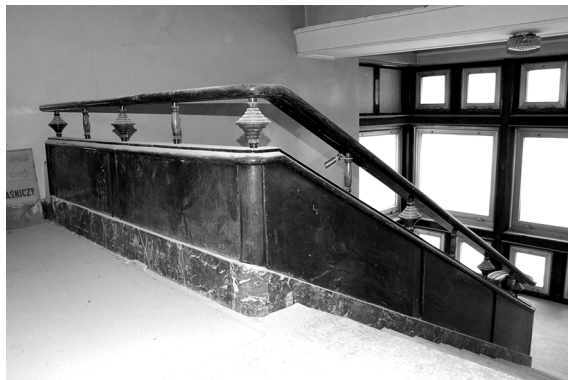
il. 31: Klatka schodowa przy pracowniach, Pałac Młodzieży w Katowicach, stan z 2013 roku, fot. A. Borowik.
