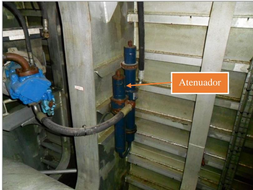
*Ilustración n° 54: Atenuador de ruido y vibraciones de la bomba eléctrica N°1.
