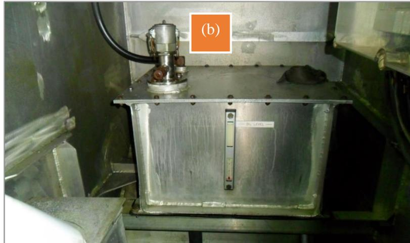
Ilustración n° 40: Tanque hidráulico de reserva.
