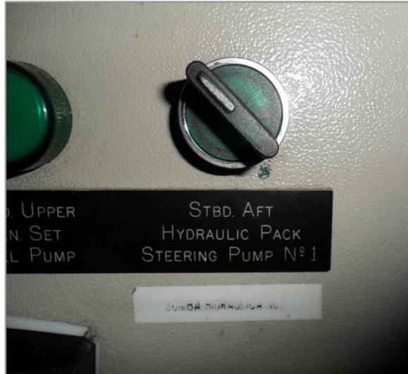
*Ilustración nº 56: Interruptor de activación de la bomba eléctrica Nº1 desde el cuadro eléctrico del ante-room.
