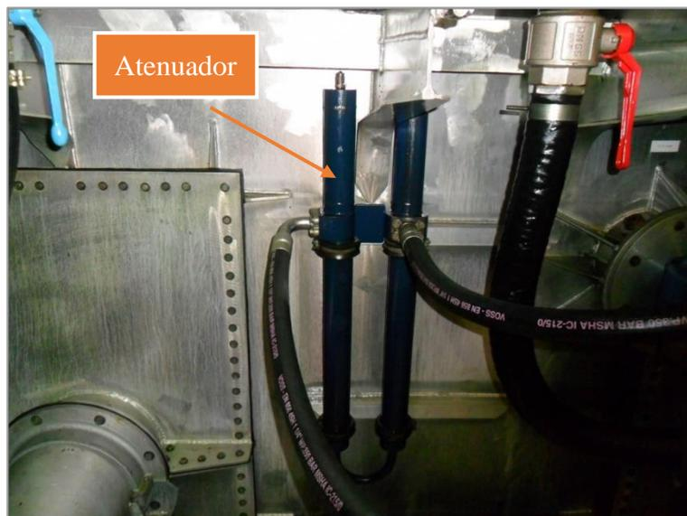
Ilustración n° 49: Atenuador de ruido y vibraciones de la bomba PTO.
