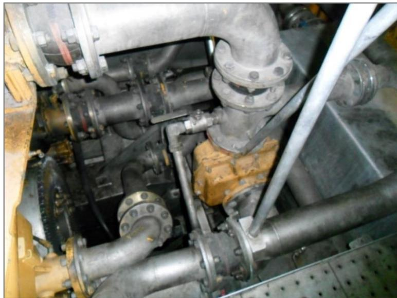
*Ilustración n° 7: Válvula termostática.
