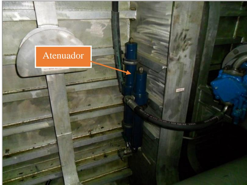
*Ilustración n° 62: Atenuador de ruido y vibraciones de la bomba eléctrica N°2.
