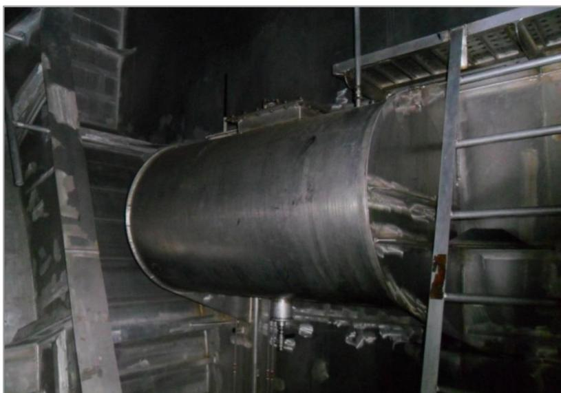
*Ilustración n° 23: Tanque combustible del motor auxiliar alto.
