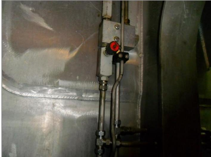
*Ilustración n° 109: Circuito que va hacia el pescante del bote de rescate y hacia el otro jet-room.
