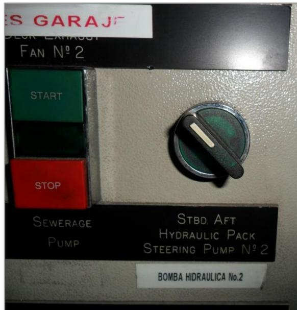
*Ilustración n° 61: Interruptor de activación de la bomba eléctrica N°2 desde el cuadro eléctrico del ante-room.
