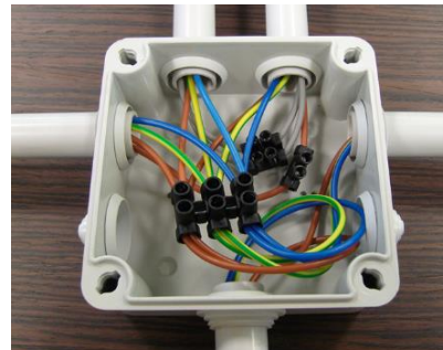
Figura 56. Caja de derivación interior
