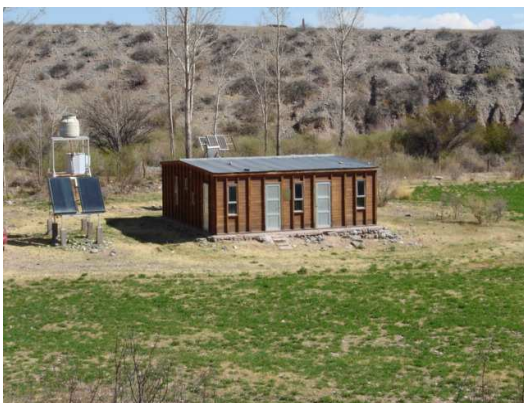
Figura 1. Refugio de la UNSa en Payogasta visto desde el Norte.
