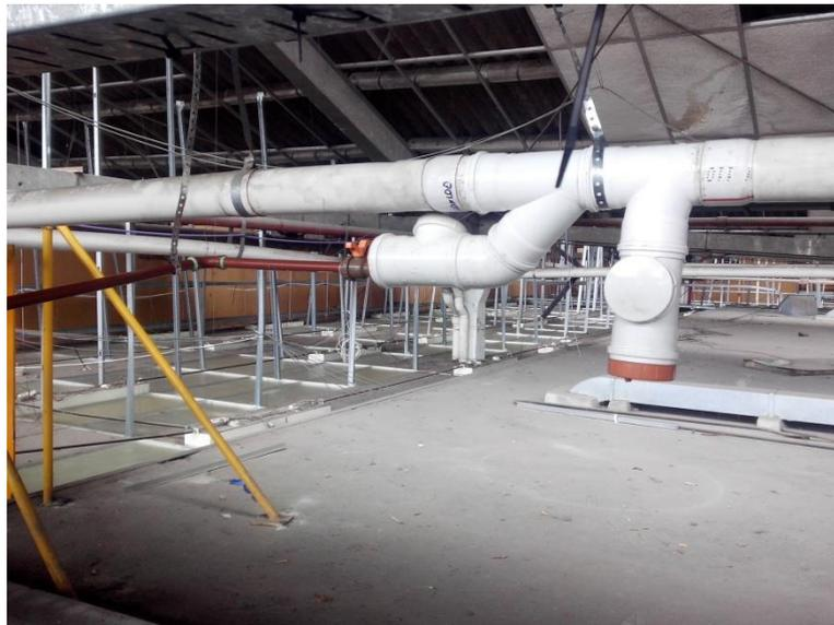
Figura 6. “Te” Filtro de sólidos (vertical) y “Te” Cartucho de resinas y carbón activado (horizontal)
