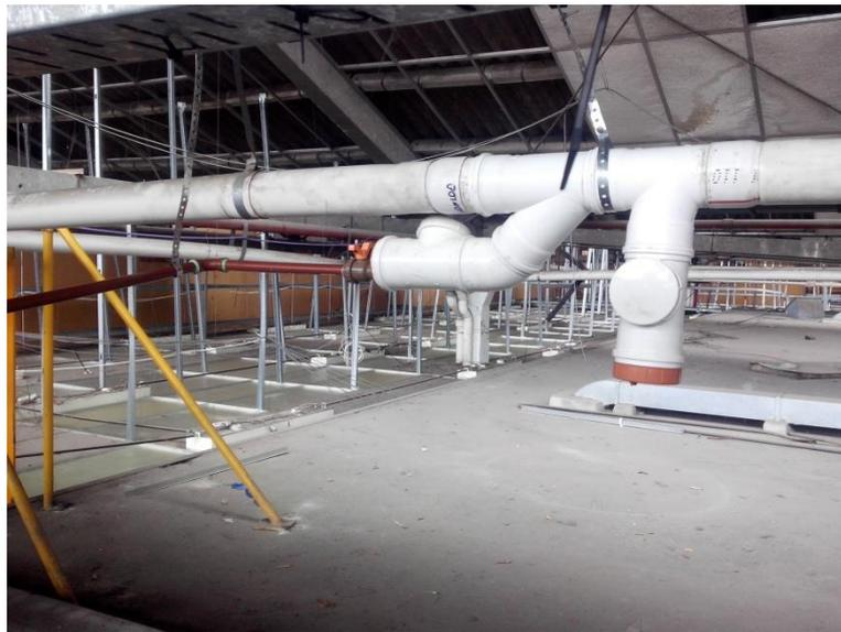
Figura 4. “Te” Filtro de sólidos (vertical) y “Te” Cartucho de resinas y carbón activado (horizontal)
