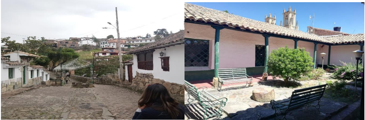
Figura 68. Monguú al fondo de la imagen, Puente Real de Calicanto. Fuente: elaboración propia. 2019
