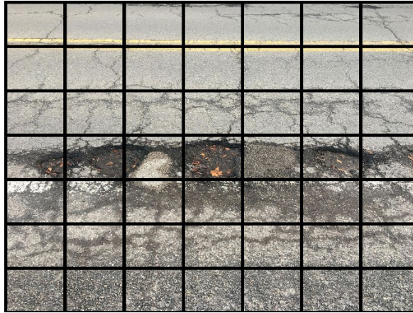
Figura 11 – exemplo de uma grelha 7x7 de imagem com Yolo.
