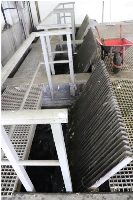
Figura 15: Gradagem da ETAR de Serzedelo II.
