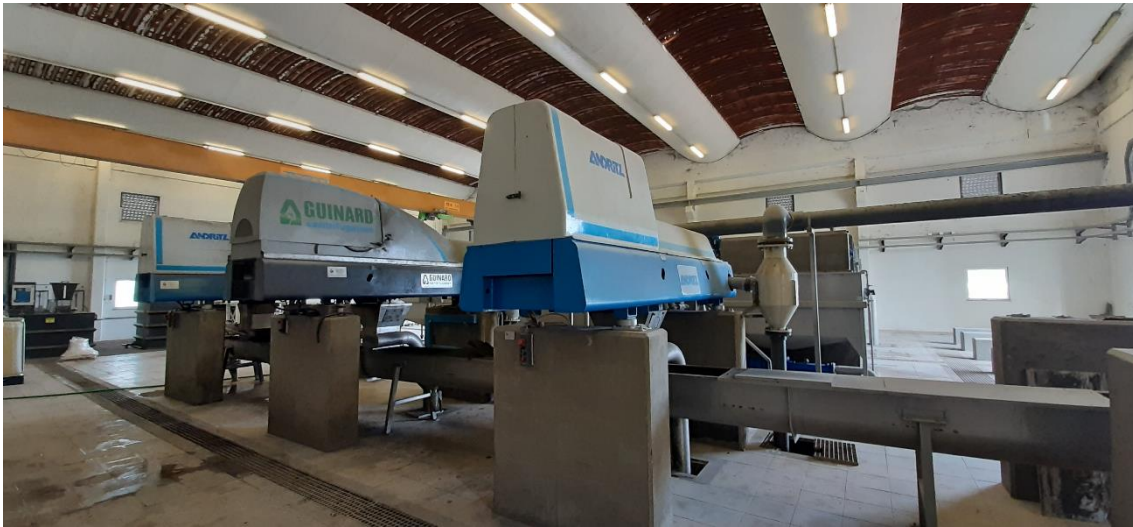
Figura 22: Centrífugas para tratamento de lamas da ETAR de Szerdelo II.
