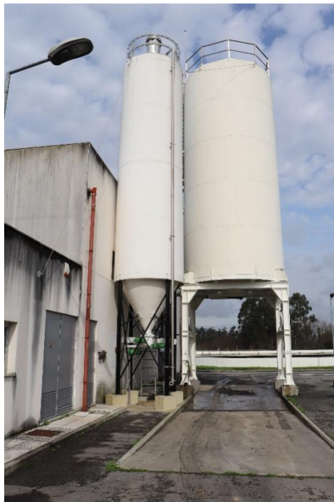
Figura 23: Silo para armazenar a lama final tratada da ETAR de Szerdelo II.
