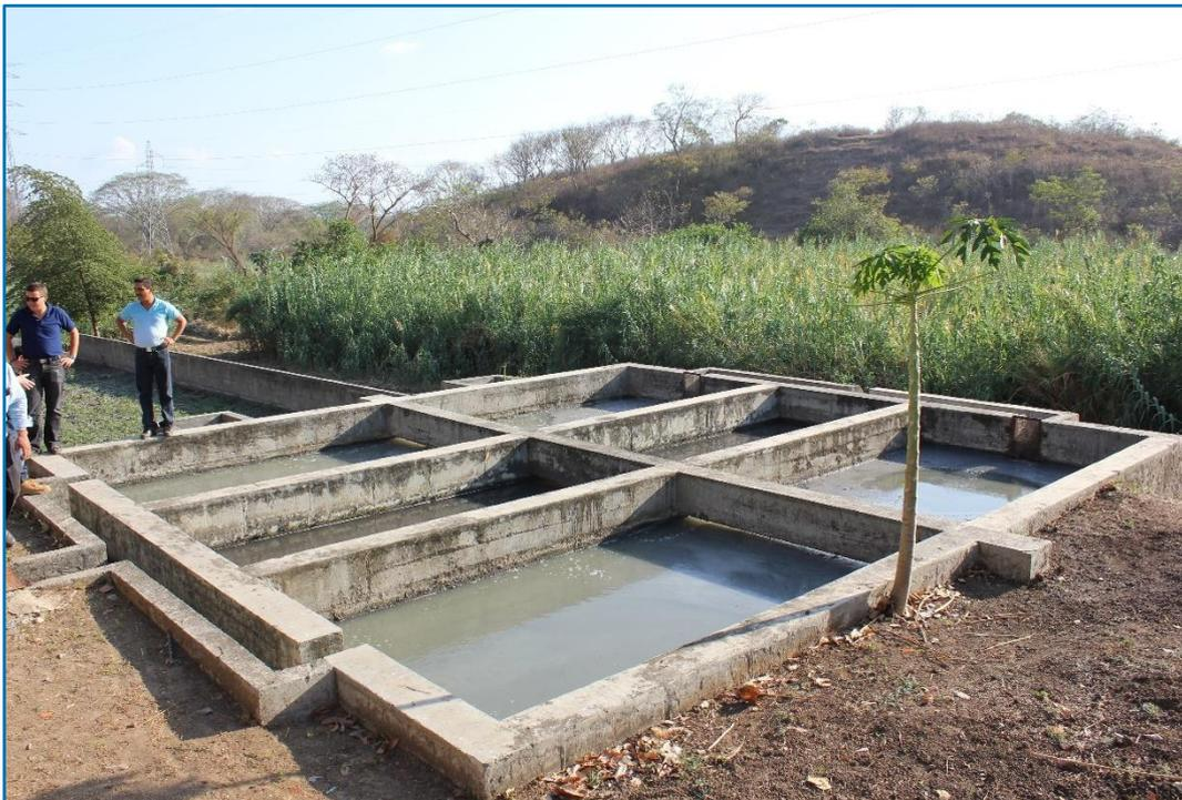
*Figura 8: Planta de tratamiento con fosas sépticas seguidas de humedales horizontales subsuperficiales. PTAR en Nicaragua*
