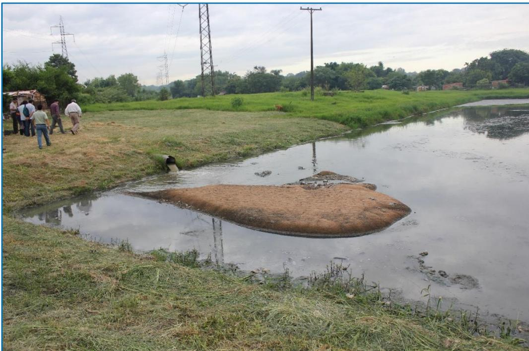
*Figura 5 Acumulación de arenas y residuos en lagunaje por ausencia de pretratamiento*
