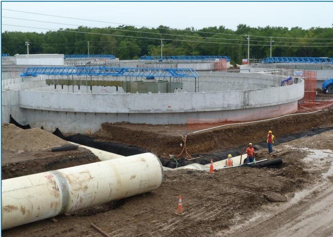
*Figura 9: Construcción de la PTAR de lodos activos de Panamá*
