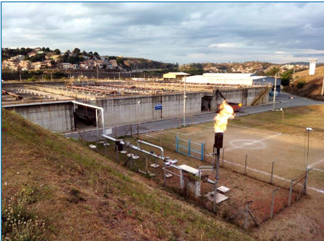
*Figura 7: Reactores anaerobios y antorcha de gas en la PTAR de Onça, Belo Horizonte, Brasil*
