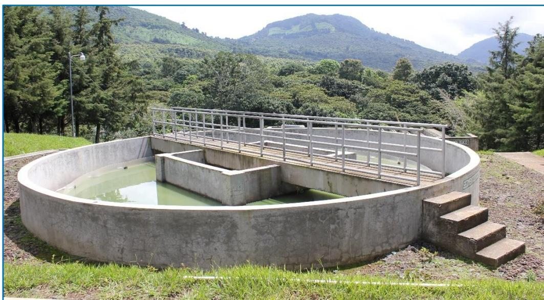
*Figura 6 Decantador primario estático. PTAR de Juayúa. El Salvador*
