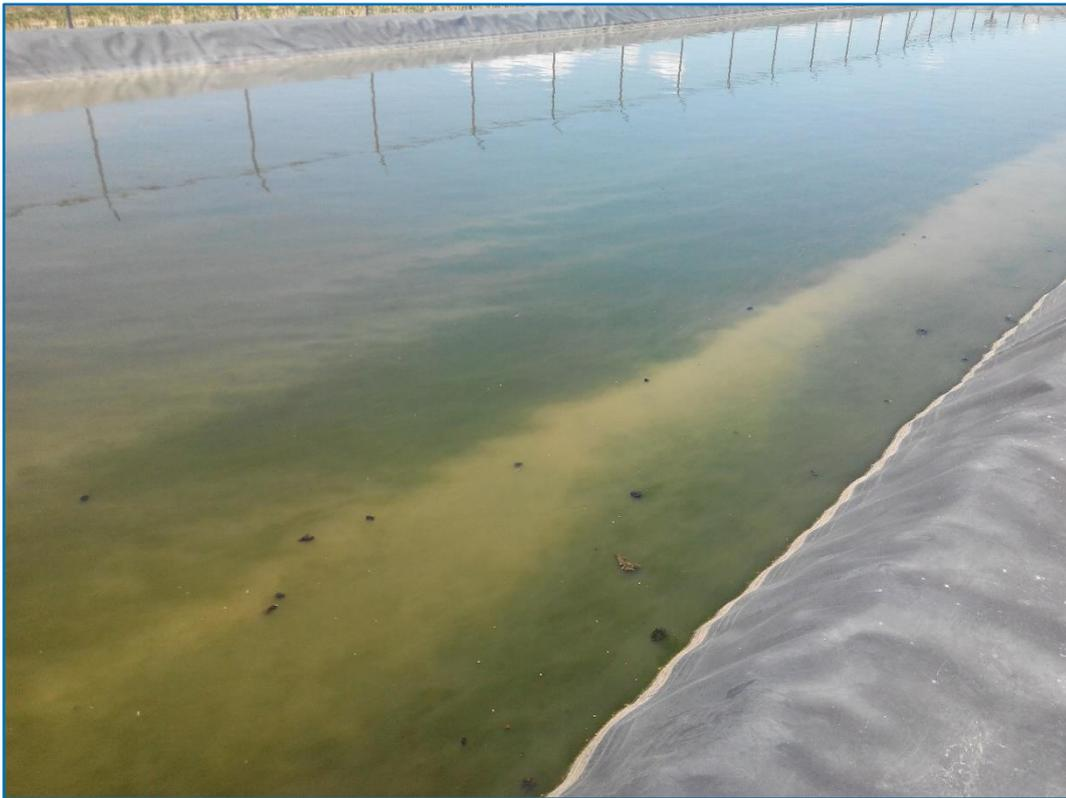
*Figura 15: Presencia de microalgas en una laguna tratamiento de aguas residuales. PTAR de Linde-Paracaya. Bolivia*
