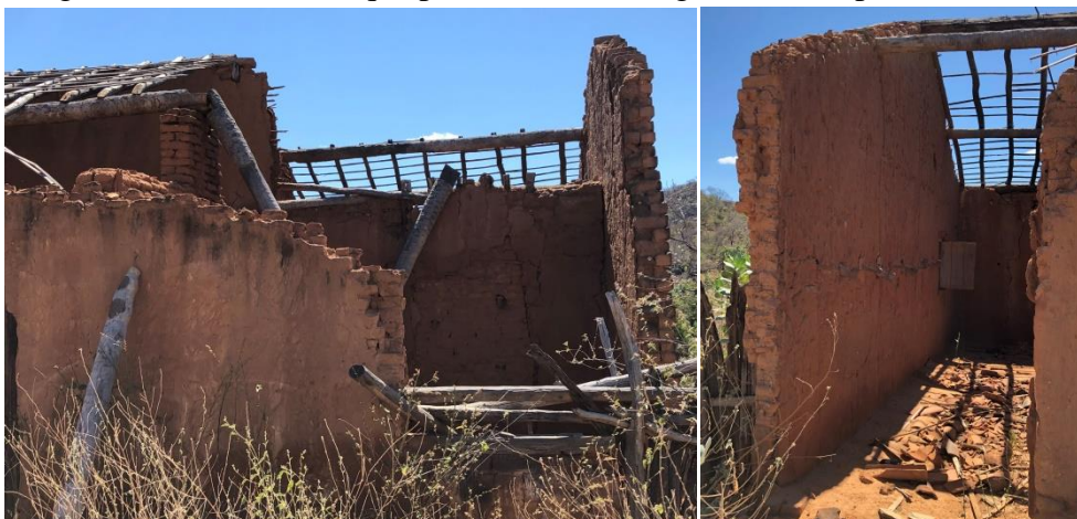
Figuras 14 e 15 - Destaque para a carnaúba e ganchos nas paredes
