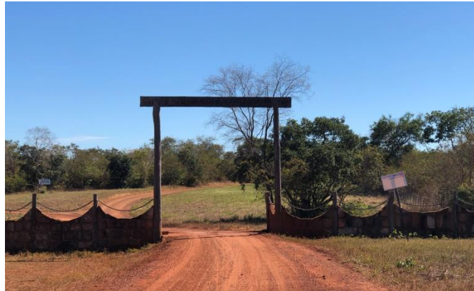
Figura 51 – Vista do portal da Serra Negra
