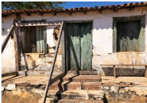
Figuras 27 - Escoras consolidando as paredes frontais da fazenda
