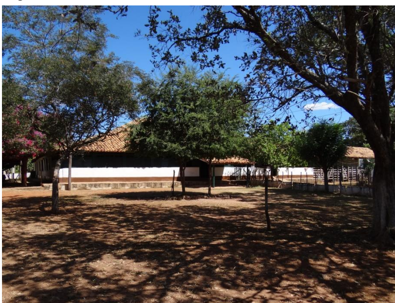
Figura 57 – Vista da casa da Abelheiras
