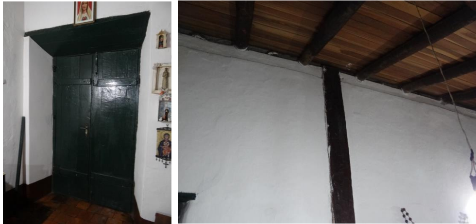
Figuras 41 e 42 - Imagem retratando a grande espessura das paredes e o esteio em aroeira encontrado
