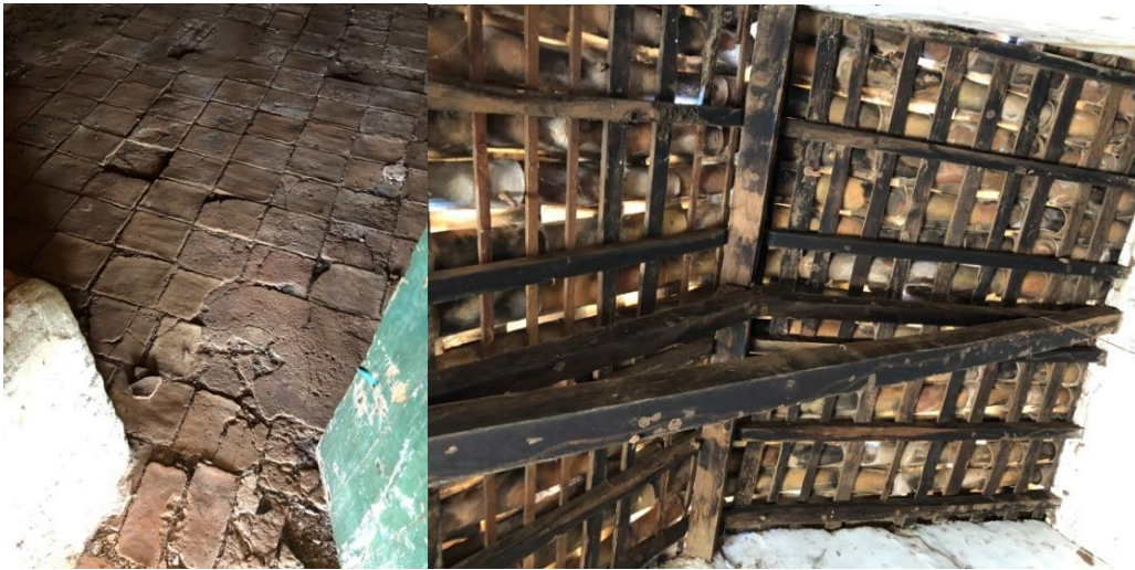
Figuras 25 e 26 - Piso em tijoleira e estrutura da cobertura em madeira e tesoura canga de porco, respectivamente da esquerda para a direita
