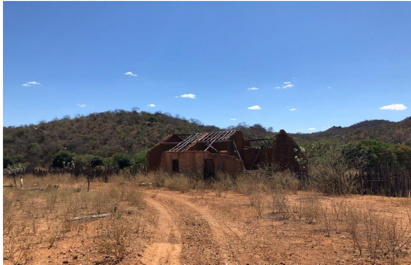
Figura 11 - Vista da casa já em ruínas
