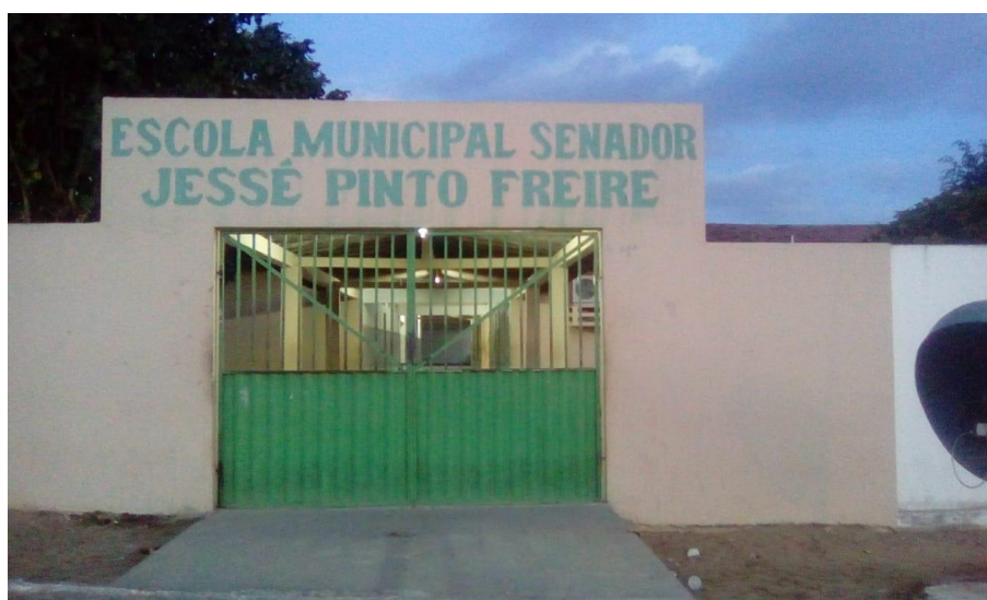
Figura 18: Vista da frente da Escola
