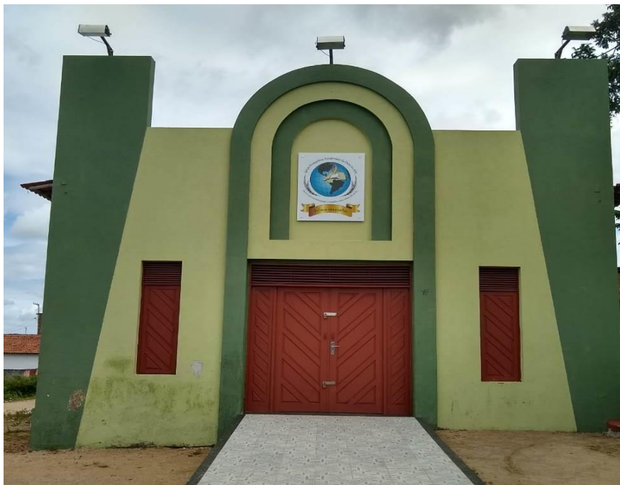
Figura 34: Igreja Evangélica da Assembleia de Deus, localizada na Sede
