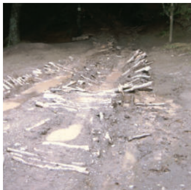
Figura 38: La ramaglia ed i residui di utilizzazione possono aumentare la portanza del terreno e ridurre gli eventuali impatti
