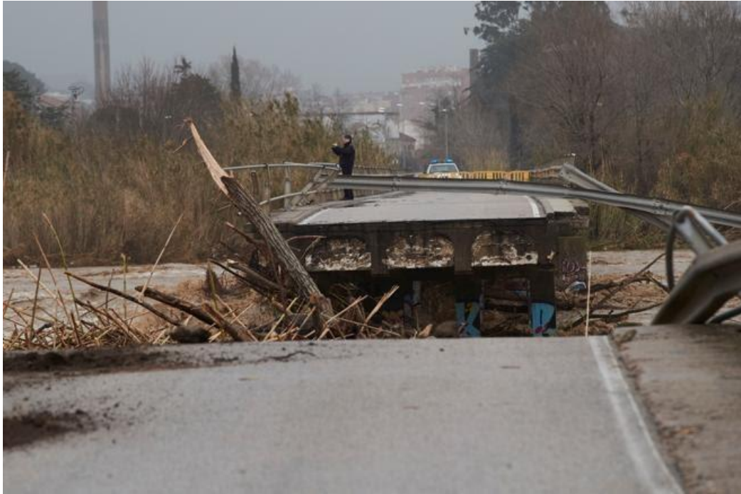
Figura 5: Trencament del pont de la carretera al Baix Tordera. Font: (Vídeo: La Borrasca "Gloria" Deja Ya Diez Muertos , n.d.)
