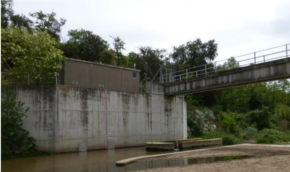
Figura 15: Estacions d'aforament de Fogars de la Selva a Can Simó (EA089)
