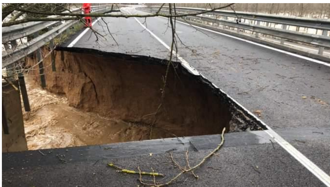
Figura 11: Esfondrament de la carretera C-35 entre Hostalric i Fogars de la Selva. Font: ( Minuto a Minuto de La Borrasca Gloria: Se Elevan a Ocho Los Muertos Por El Temporal , n.d.)
