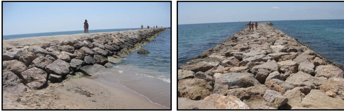
Figura 4: dos perspectivas de un espigón en talud
