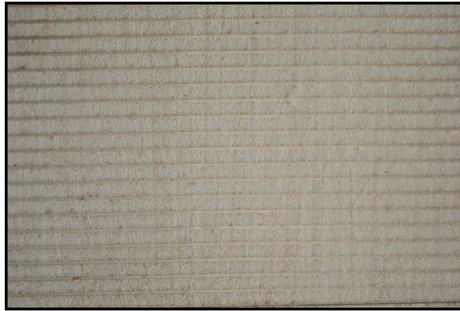
Figura 9: Detalle aspecto final del pavimento de hormigón
