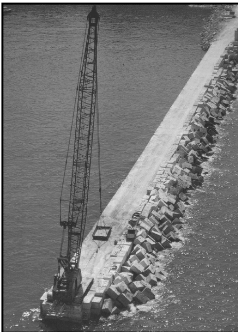
Figura 7: Imágenes de la construcción de diques en talud mediante la vía terrestre
