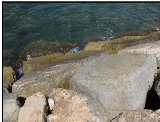
Figura 6: Elementos de escollera colocados formando un manto principal
