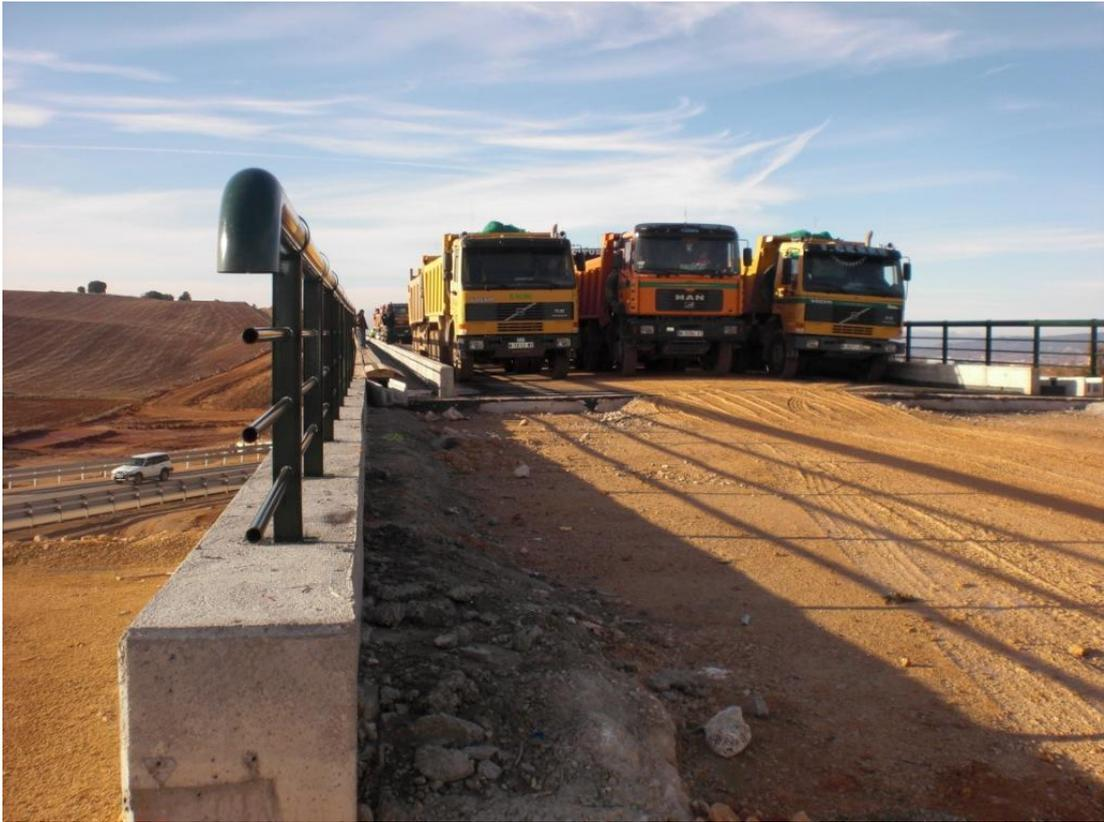
*Fig. Anexo D 5. Viaducto cargado visto desde estribo en hipótesis7 (cargado vano 4 y5).*
