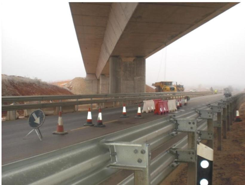
Fig. 46. Desvío del tráfico hacia los arcenes para la colocación del potenciómetro en centro del vano 3.
