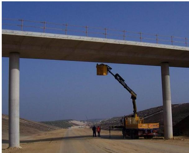
*Fig. 54. Colocación de cable de acero bajo el tablero en el punto a instrumentar.*
