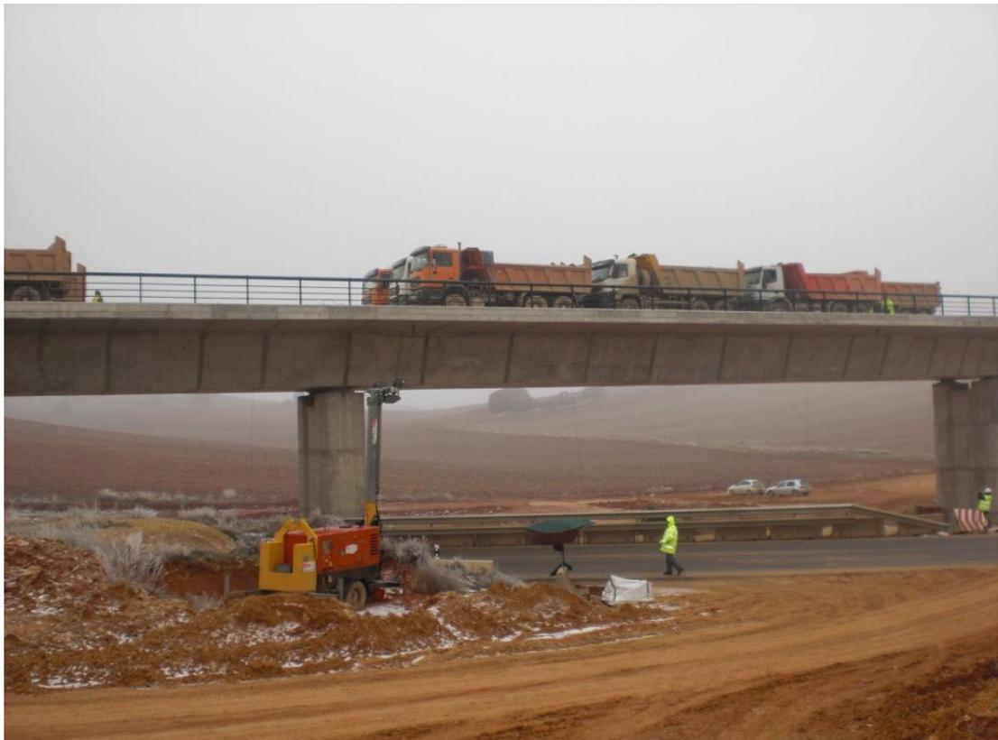
*Fig. Anexo D 2. Viaducto cargado en Hipótesis de carga 2 (cargado vano 2 y 3)*
