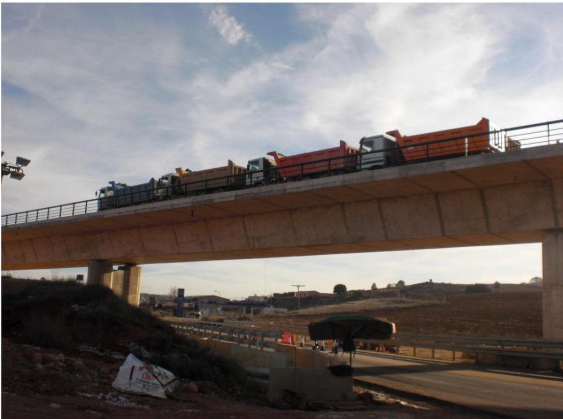
*Fig. Anexo D 4. Viaducto cargado en Hipótesis de carga 3 (cargado vano 2 y 3)*
