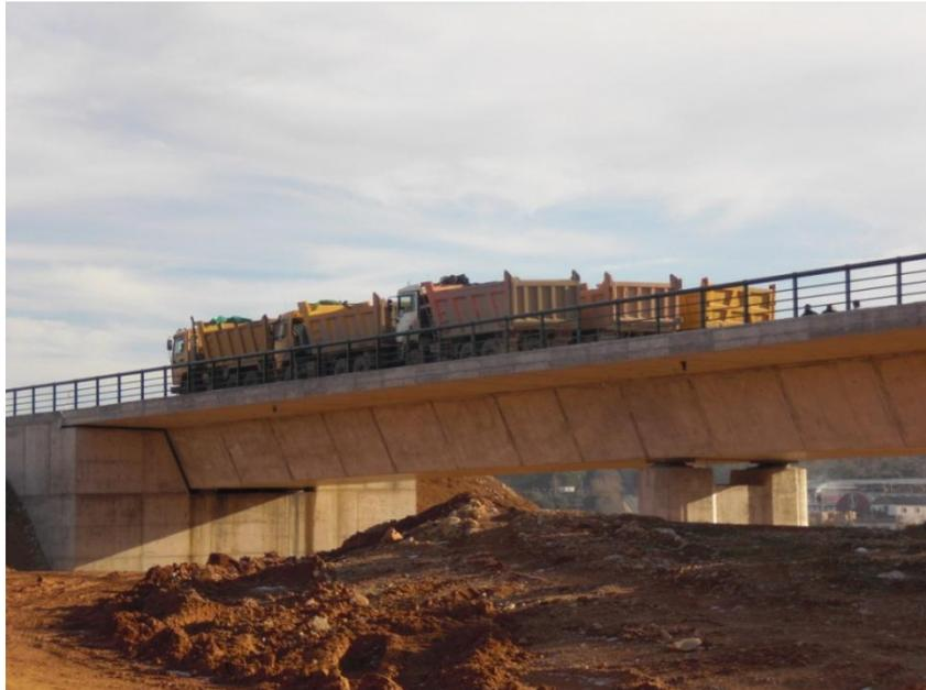
*Fig. 55 Camiones cargados colocados en vano 5.*
