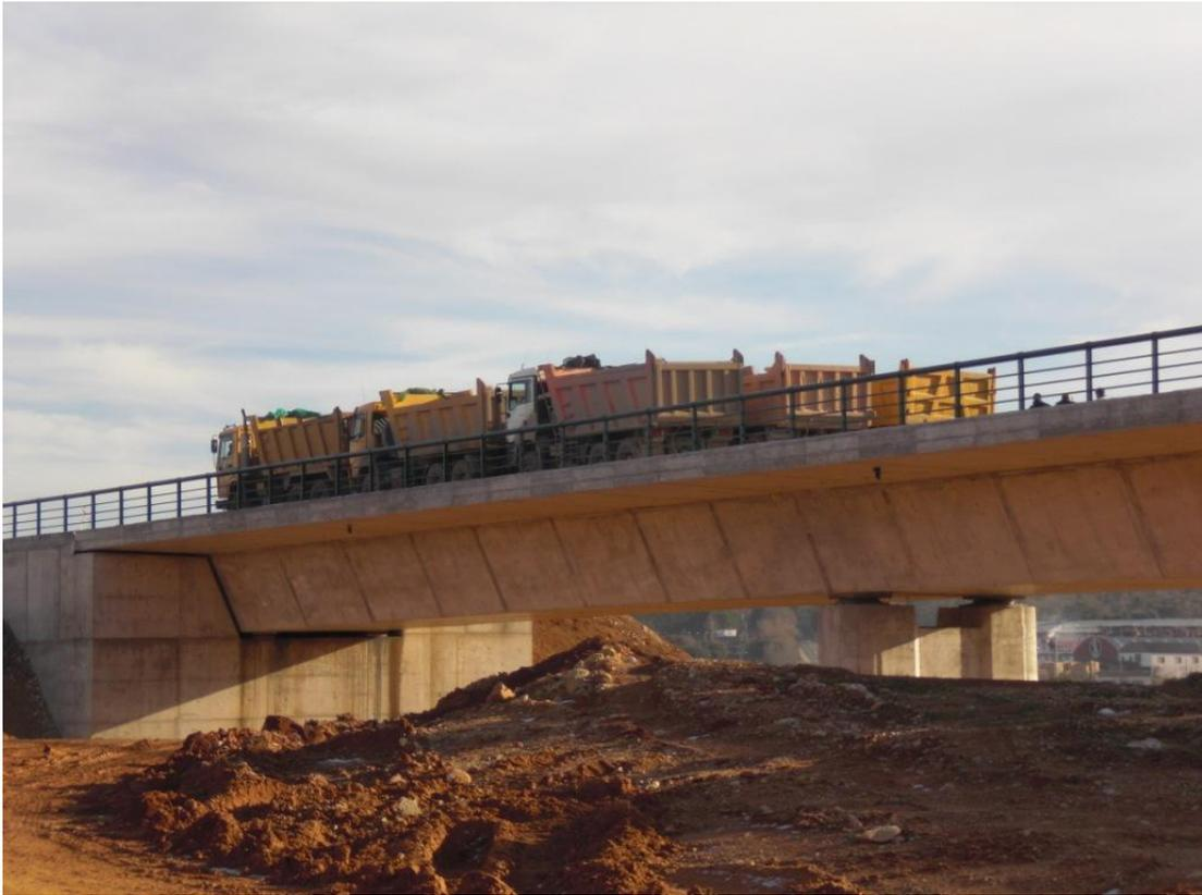
*Fig. Anexo D 3. Viaducto cargado en Hipótesis de carga 6 (cargado vano 3 y 6)*
