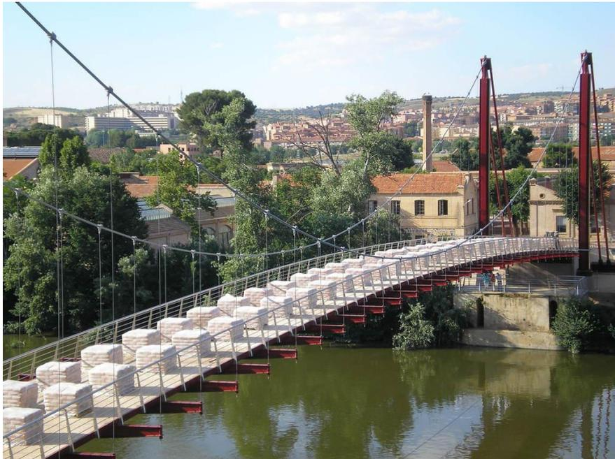
Fig. 7. Puente de armas (Toledo). Prueba de carga con sacos de cemento.
