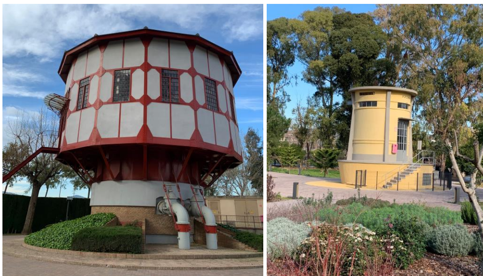
Figura 7.15. Pous de captació d'aigua subterrània aqüífer del riu Llobregat
