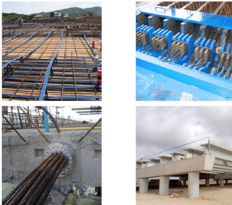
Figura 1.1: Armadura postesa VS armadura pretesa
