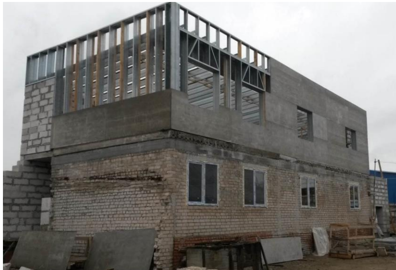
Рисунок 1. – Общий вид здания с каркасом второго этажа и обшивкой наружной стороны листами ЦСП
