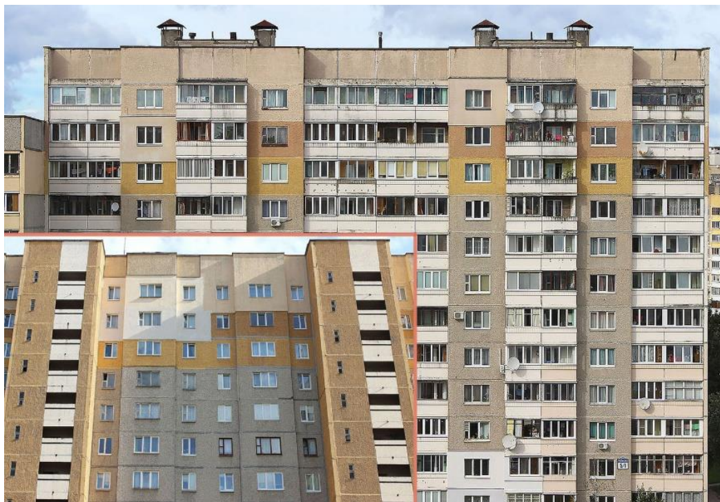
Рисунок 2. – Фасады северной (слева внизу) и южной ориентации двух расположенных друг напротив друга 12-этажных жилых зданий серии М111-90
