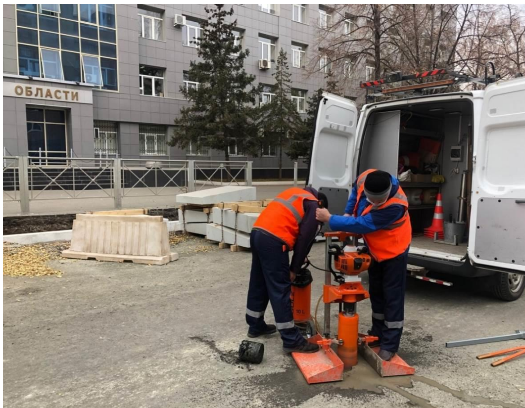
Рисунок 1. – Отбор образцов покрытия проезжей части ул. Комсомольская, город Оренбург
