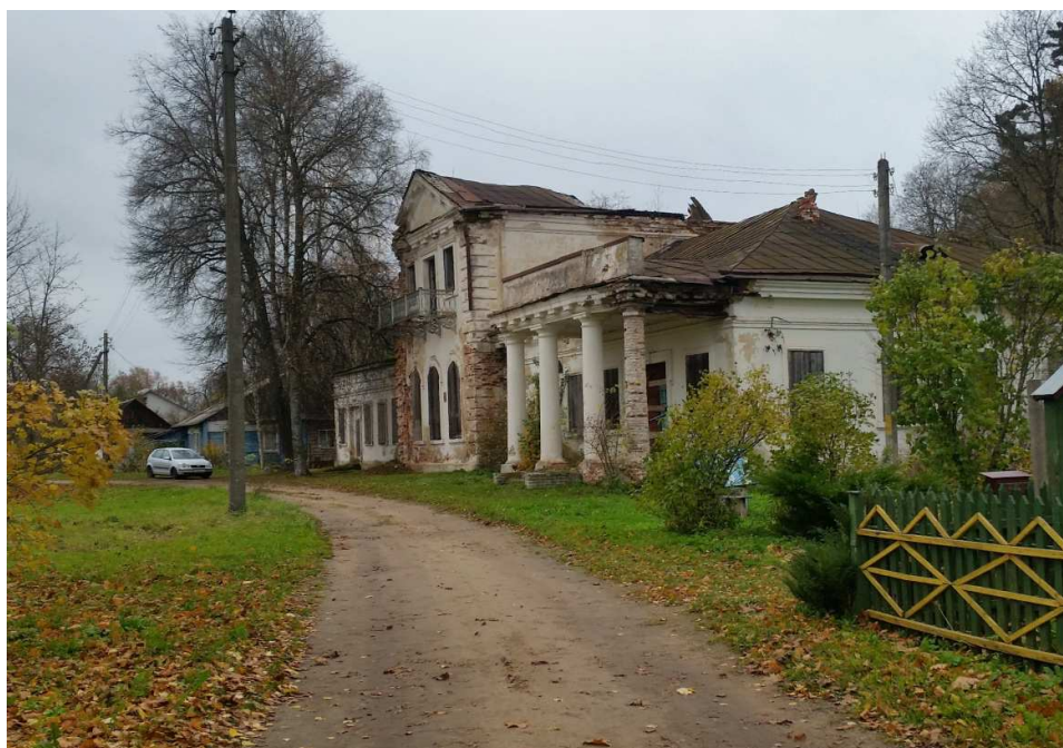
Рисунок 1. – Современное состояние здания усадебно-паркового комплекса Гребницких
