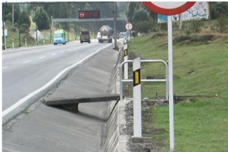
Fuente: revisión manual de drenaje bajo criterio de seguridad vial. Paso de cuneta bajo vía (rampa).
