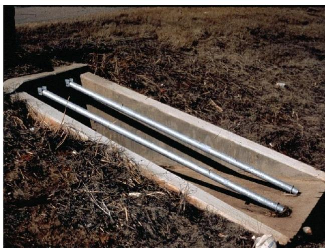
Fuente: Revisión manual de drenaje bajo criterio de seguridad vial. Salida de drenaje subsuperficial traspasable.
