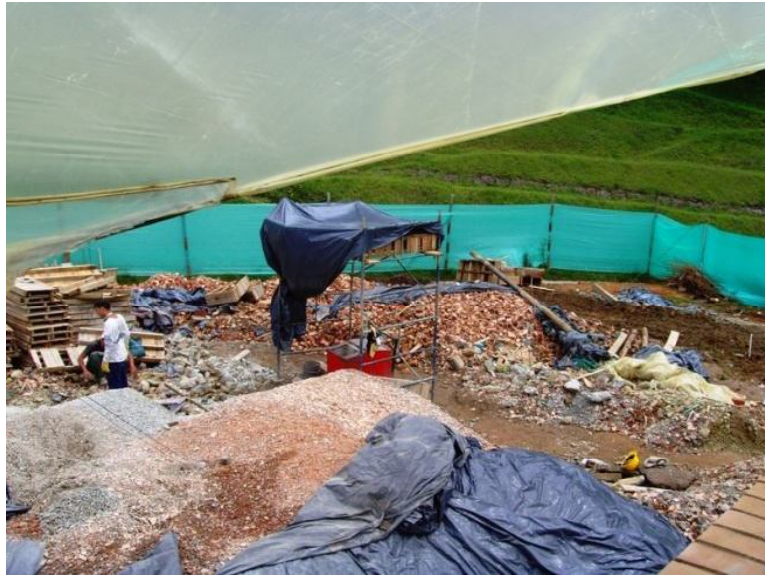
Ilustración 5. Sitio de acopio material reciclado Fuente: Propia, año 2011
