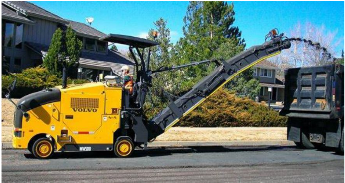
Ilustración 2. Fresado y reciclado de asfalto
