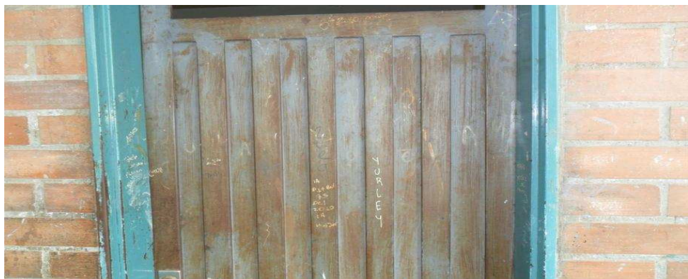
Figura 21. Corrosión en elemento metálico de tragaluz.
