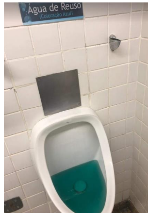
Figura 8: Banheiro do Shopping Continental em São Paulo
