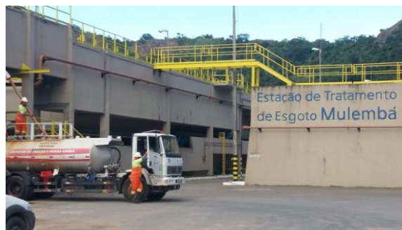
Figura 6: Abastecimento do caminhão pipa com água de reúso na ETE Mulembá em Vitória/ES
