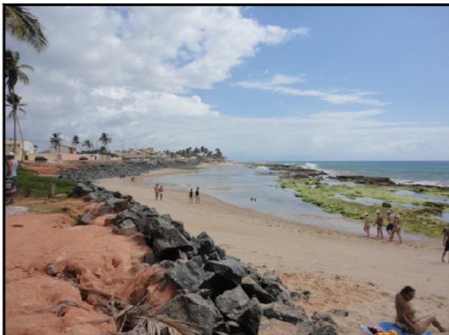
**Foto 3.** Estrutura rígida de contenção à erosão na praia de Jauá.
