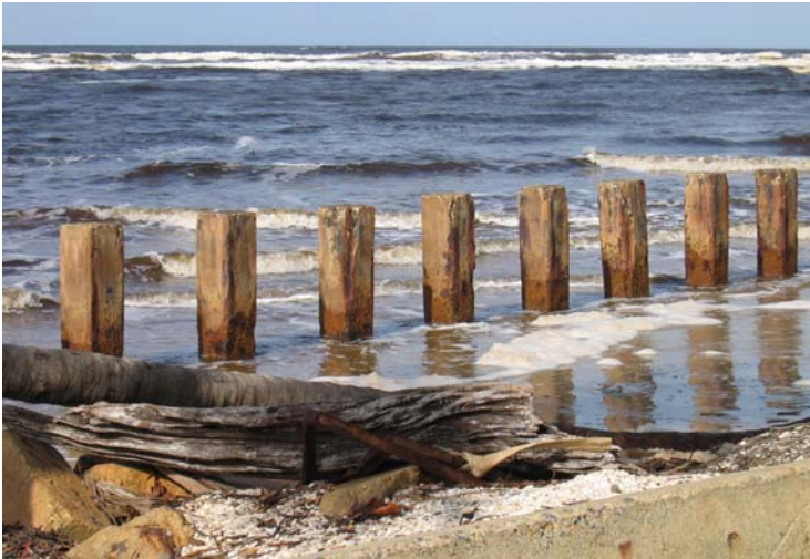
<그림 4-9> 해안도로의 침식을 막기 위하여 설치했던 콘크리트 말뚝 시설
