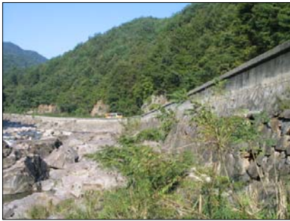
<그림 2-7> 산림과 하천을 단절하고 있는 도로의 콘크리트 직벽
