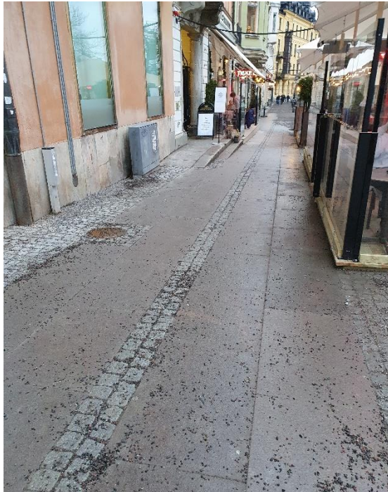
Figur 13. Infällda granitblock i smågatstenen ger en slät yta för de gående. Även det ett exempel på hur Bra miljö för gående kan appliceras så att framkomligheten på ytor med smågatsten tillgodoses samtidigt som de båda granitmaterialen ger en samlad karaktär. Foto: Ludvig Pärlefors [2021-02-23]
