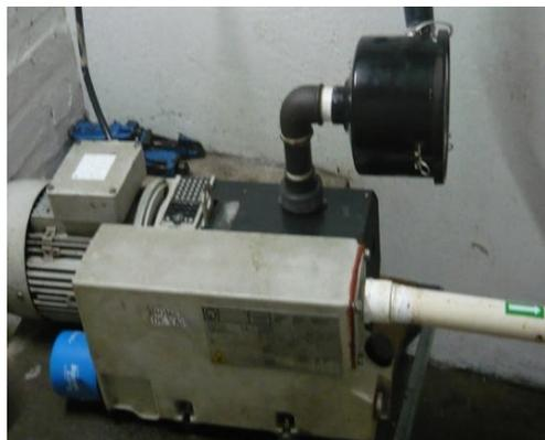
Figura G-2. Bomba de vacío.
