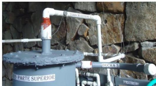
Figura G-6. Lugar de muestreo a la salida de los biofiltros y sistema de riego de los lechos
