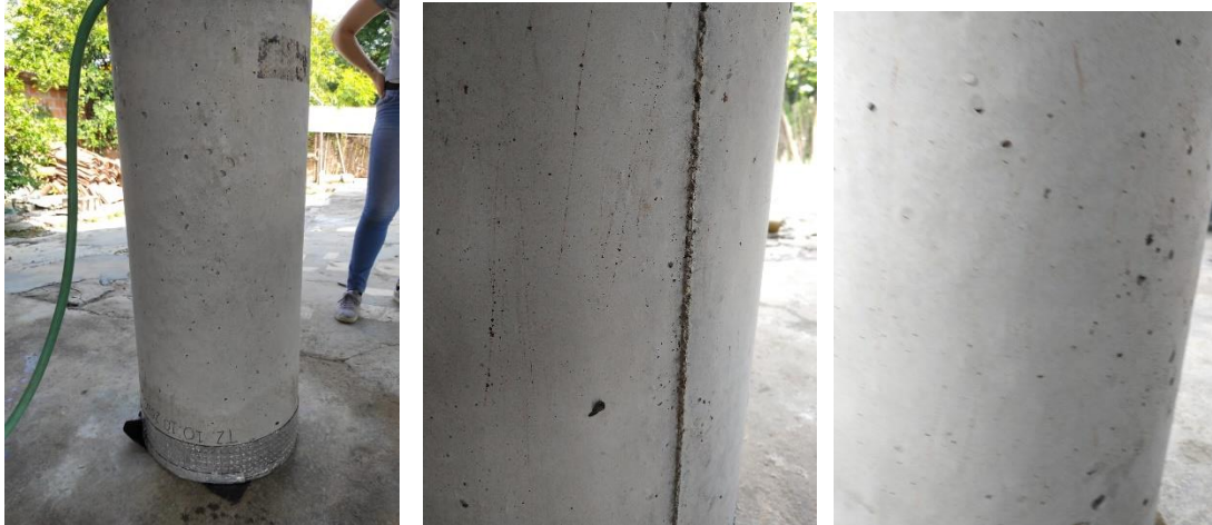
Figura 18. Montaje (izquierda) e inspección (centro y derecha) de ensayo de permeabilidad de tubos de concreto.
