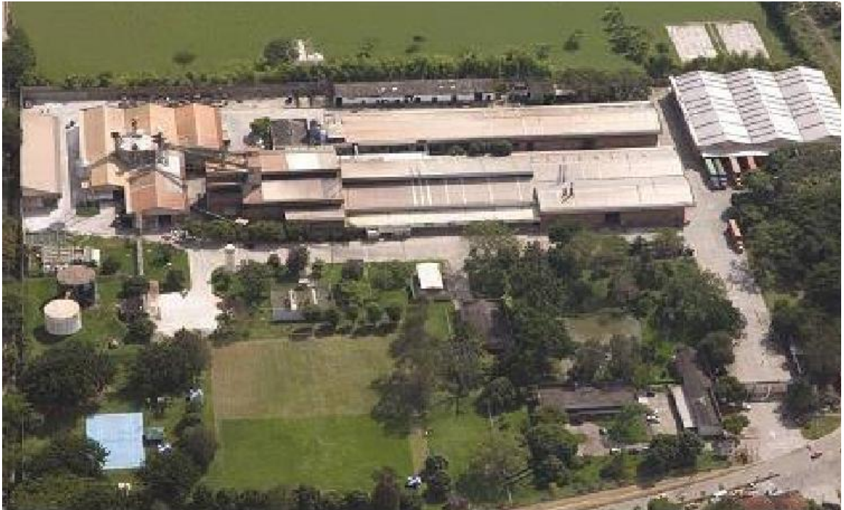
Figura 3. Vista Aérea Planta Guadalajara de Buga – Valle del Cauca
